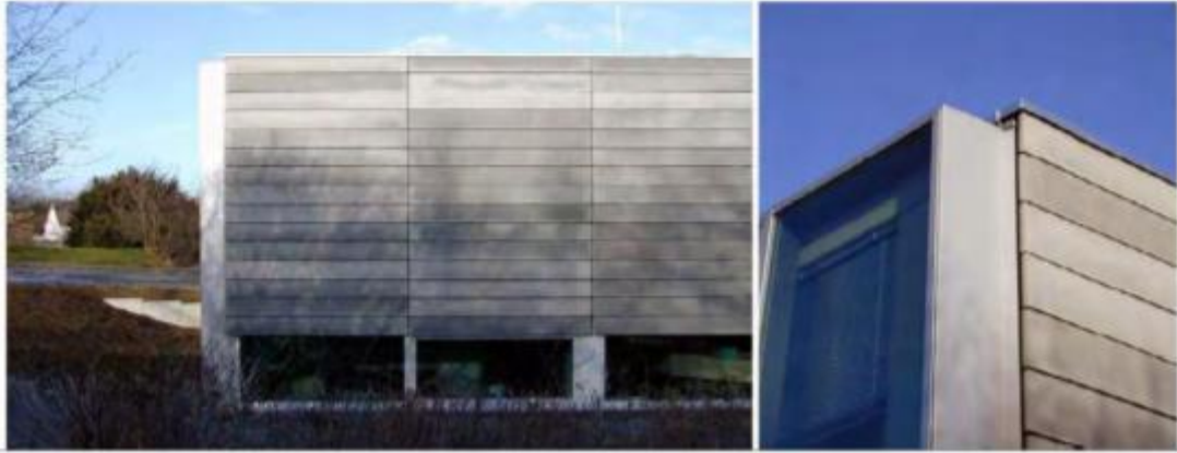
Σχήμα 2.4.1: Κάλυψη εξωτερικής επιφάνειας με στοιχεία IAM [13].
