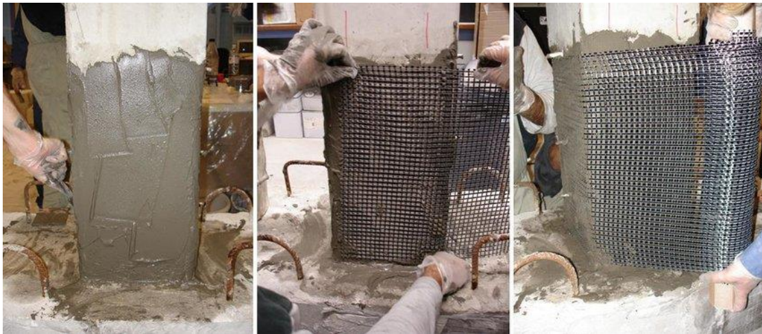
Σχήμα 2.4.4: Ενίσχυση τοιχοποιίας με μανδύα IAM [15].
