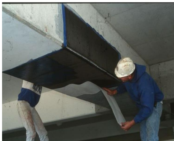
Σχήμα 2.1.4: Ενίσχυση δομικού στοιχείου με ΙΟΠ [5].
