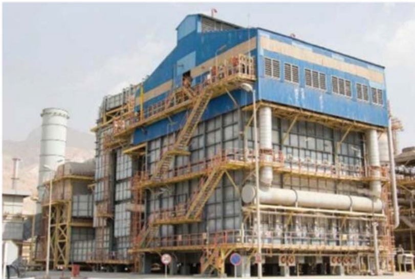
Σχήμα 2.1: (α) Σχηματική απεικόνιση της διεργασίας αναμόρφωσης μεθανίου με ατμό [14] και (b) Φούρνος αναμόρφωσης ατμού (steam reformer) [25].
