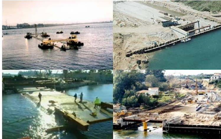
Εικόνα 3. 4 Φωτογραφίες από την κατασκευή της Υποθαλάσσιας Σήραγγας Πρέβεζας-Ακτίου.
