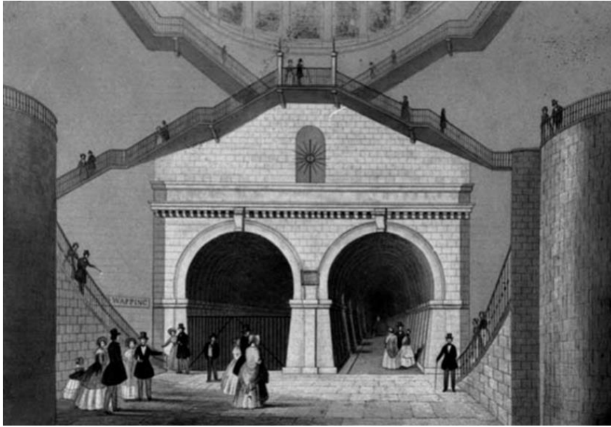
Εικόνα 3. 5 Αναπαράσταση της εισόδου της Υποβρύχιας Σήραγγας στον Τάμεση Ποταμό στο Warring, από αποτύπωση λιθογραφίας του 1836 σε χαρτί.
