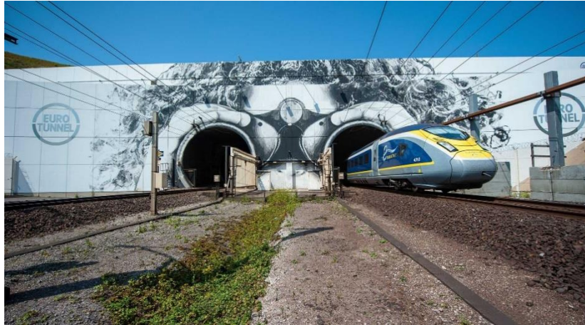
Εικόνα 3. 9 Φωτογραφία μέρους του σιδηροδρομικού τμήματος της Σήραγγας της Μάγχης.
