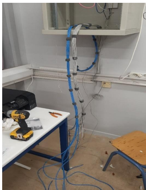
Εικόνες 23, 24, 25:Οργάνωση UTP καλωδίων και τερματισμός στα patch panels
