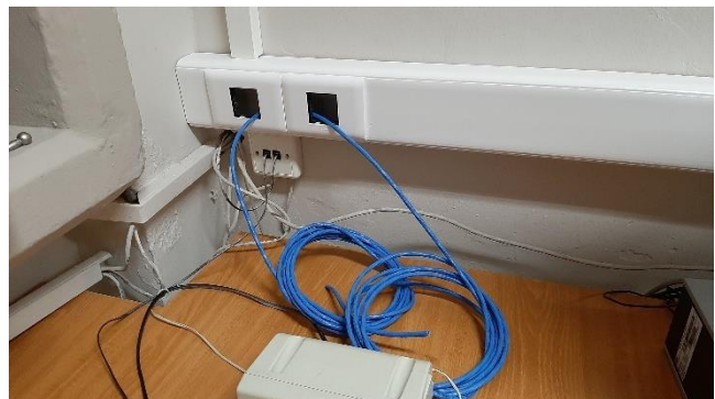
Εικόνες 20, 21, 22: Διέλευση καλωδίων UTP από τα ικριώματα προς τις πρίζες δικτύου
