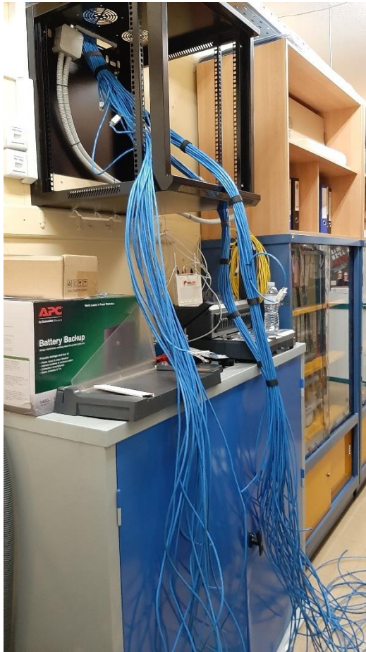
Εικόνες 20, 21, 22: Διέλευση καλωδίων UTP από τα ικριώματα προς τις πρίζες δικτύου
