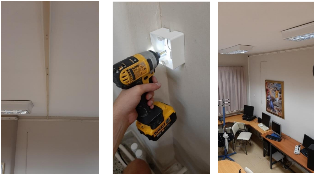
Εικόνες 14, 15, 16: Εγκατάσταση καναλιών διέλευσης καλωδίων και πλαισίων πριζών δικτύου.
