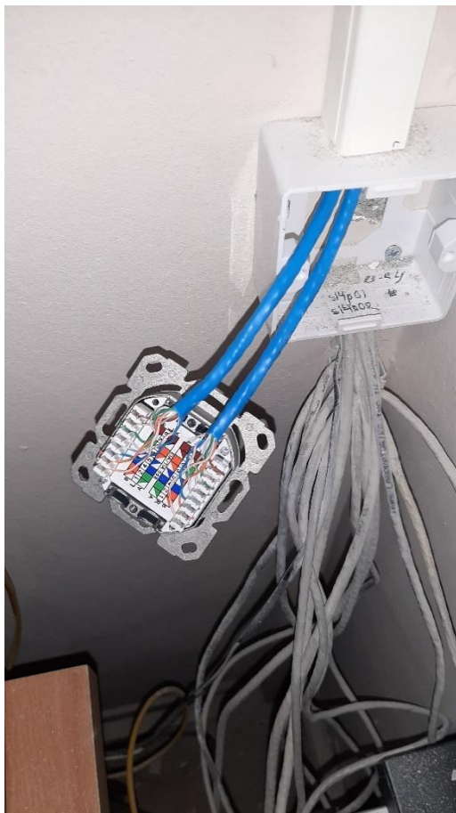
Εικόνες 26, 27: Τερματισμός καλωδίων UTP στις πρίζες δικτύου.
