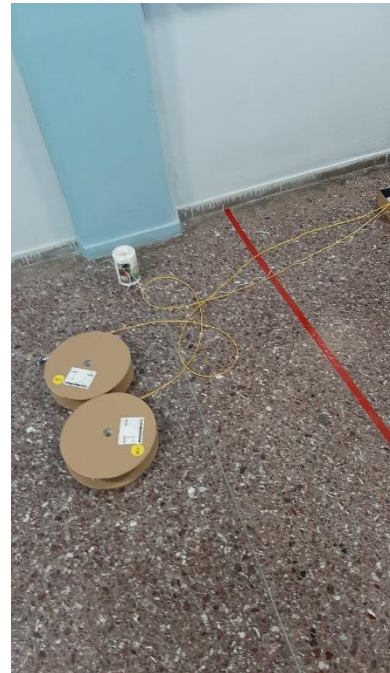
Εικόνες 17, 18, 19: Διέλευση Οπτικών Ινών από το κεντρικό Ικρίωμα προς τα περιφερειακά
