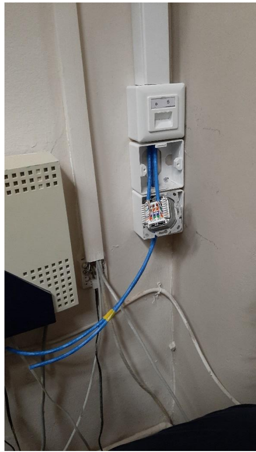
Εικόνες 26, 27: Τερματισμός καλωδίων UTP στις πρίζες δικτύου.
