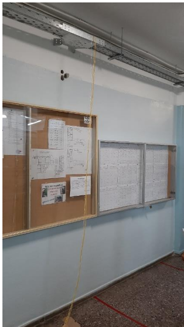
Εικόνες 17, 18, 19: Διέλευση Οπτικών Ινών από το κεντρικό Ικρίωμα προς τα περιφερειακά
