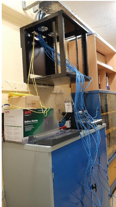
Εικόνα 10: Νέο κεντρικό Ικρίωμα
