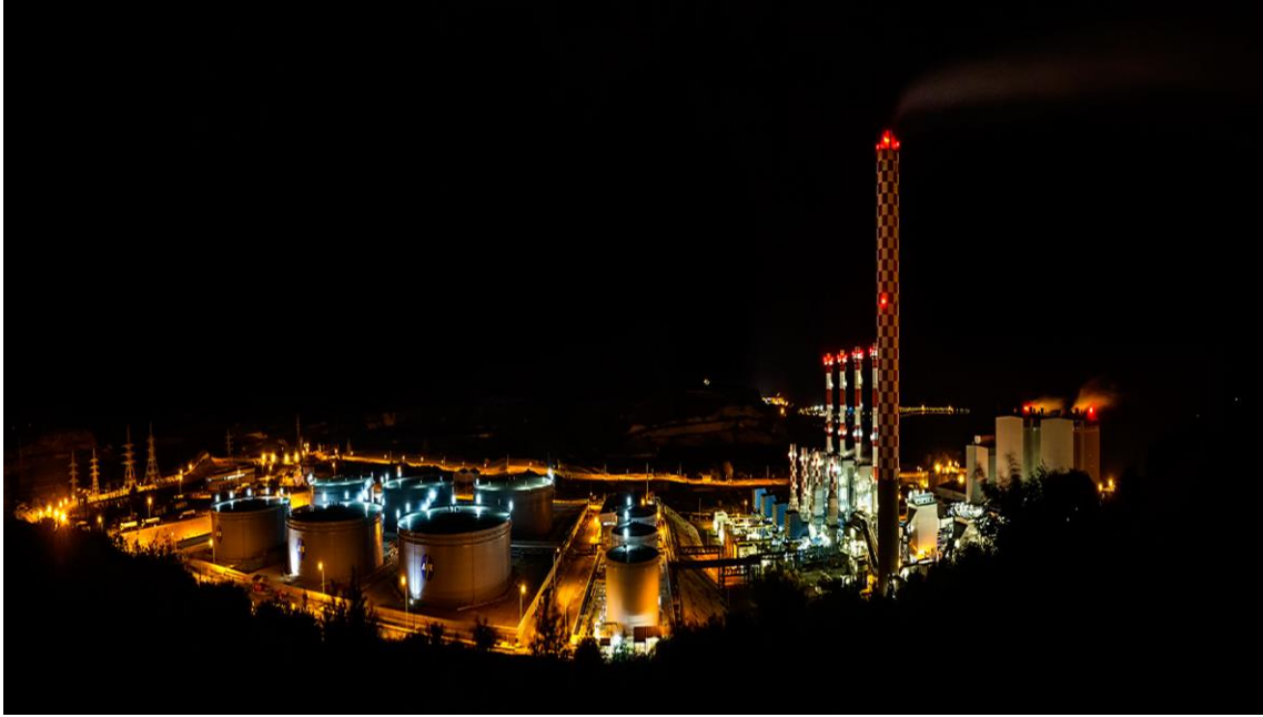
Εικόνα 2.3: Ηλεκτροπαραγωγός Σταθμός Μονής
