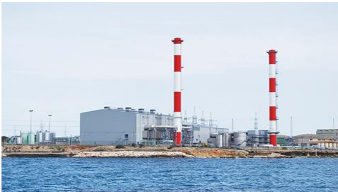
Εικόνα 2.2: Ηλεκτροπαραγωγός Σταθμός Δεκέλειας
