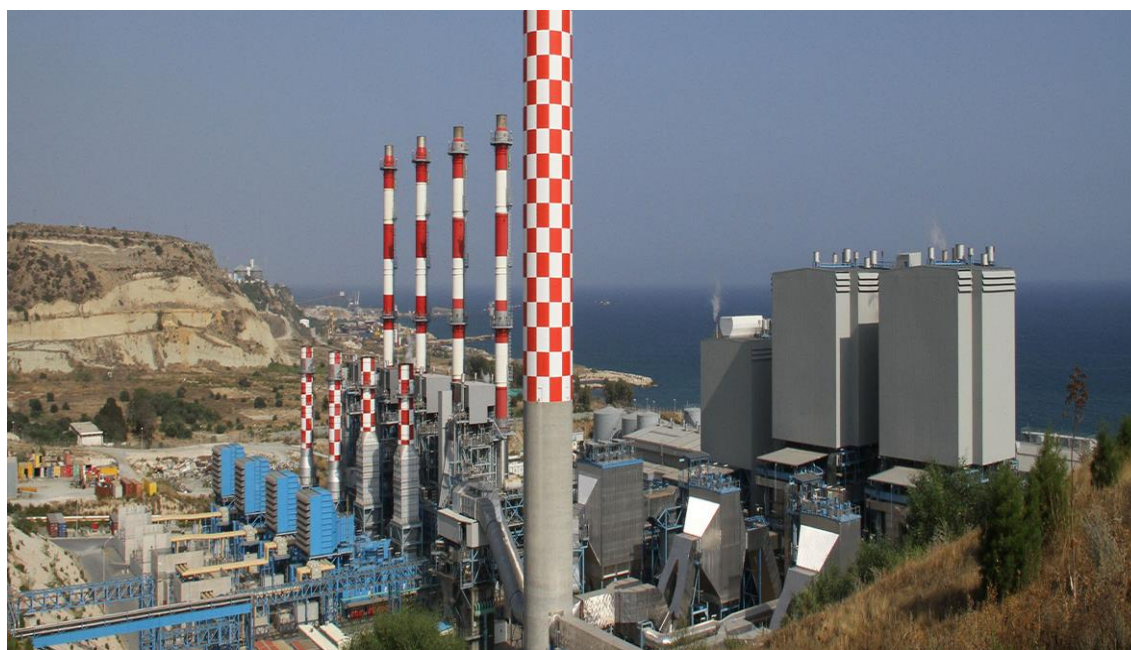
Εικόνα 2.1: Ηλεκτροπαραγωγός σταθμός Βασιλικού
