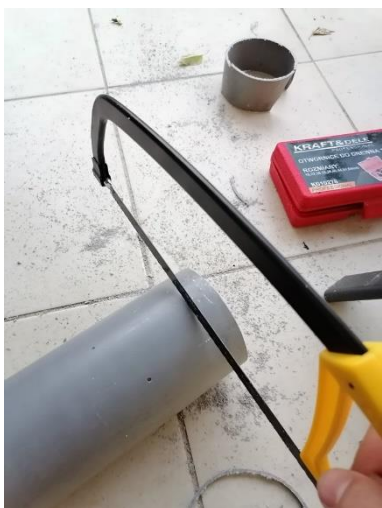
Εικόνα 3.8 (Κοπή σωλήνα PVC)
