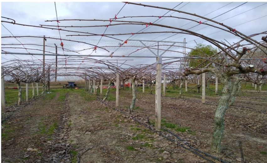
Εικόνα 1: Κατασκευή ΤΑΦ σε ακτινιδιοφυτεία στην περιοχή Κεραμωτή, Καβάλας 14/03/19
