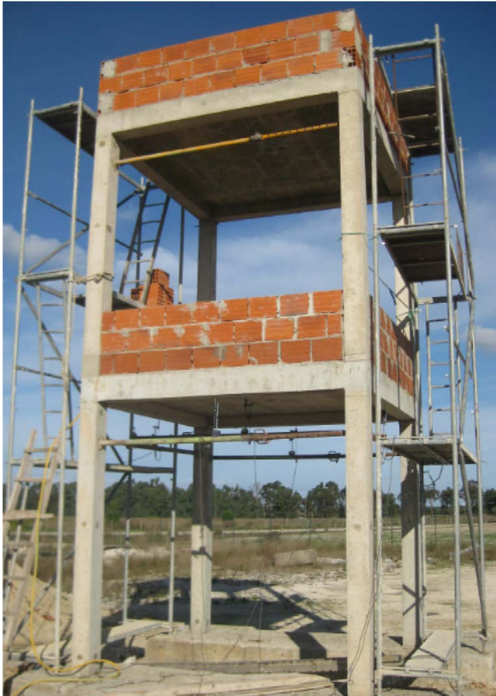
Σχήμα 4.18: Όψη δώροφου πλαισίου με σκυρόδεμα από ΑΑ [133]
