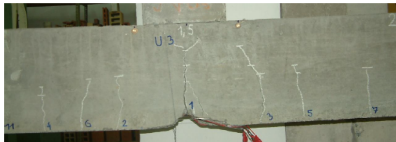
Σχήμα 4.9: Σχηματισμός ρωγμών κατά τη φόρτιση και τελική μορφή μετά την αστοχία [114]
