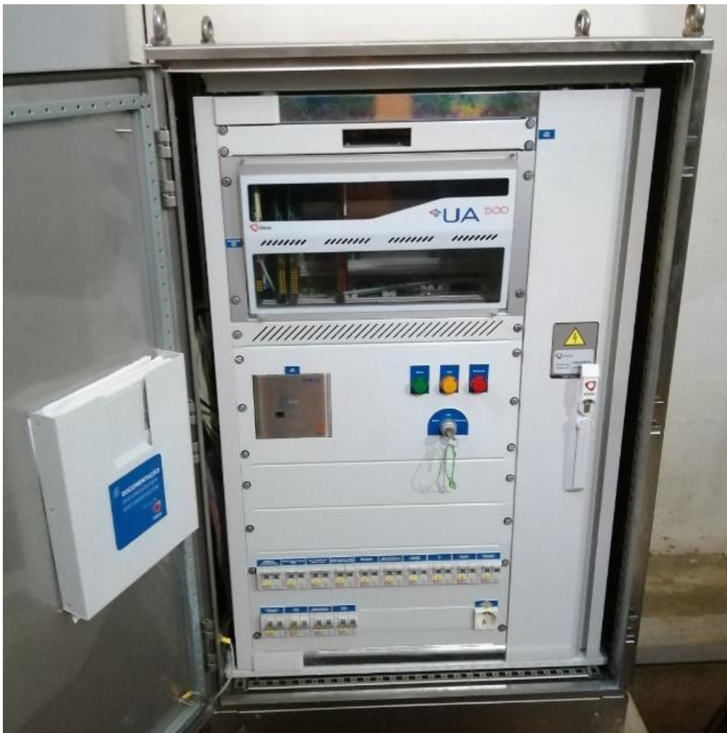
Σχήμα 3.1. Απομακρυσμένη Τερματική Μονάδα - Remote Terminal Unit - RTU (Πηγή ΔΕΔΔΗΕ)
