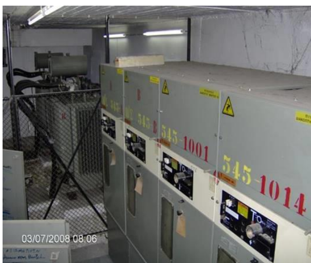
Σχήμα 6.4. Εγκατεστημένοι Δ/Φ σε Υ/Σ ΜΤ/ΧΤ, εσωτερικού χώρου (αριστερά) και μονογραμμική διάταξη (δεξιά) - (Πηγή ΔΕΔΔΗΕ)
