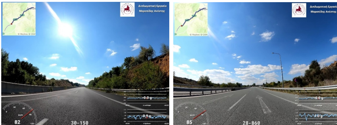
Εικόνες 5.7.3.3 και 5.7.3.4 Ενδεικτικές θέσεις εμφάνισης παλιάς διαγράμμισης Χ.Θ. 30+150 και οριζόντιας σήμανσης που απαιτεί συντήρηση και Χ.Θ. 28+860 (Αριστερός κλάδος) (Πηγή : Προσωπικό Αρχείο)
