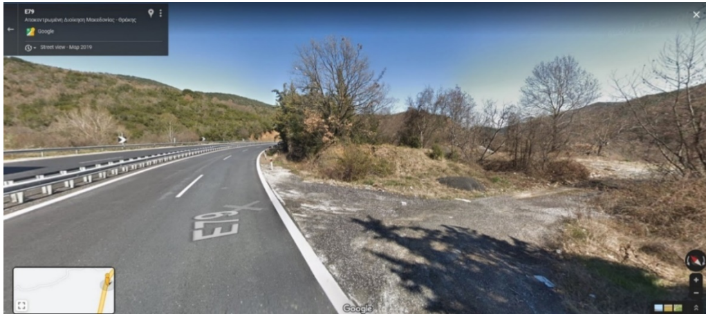
Εικόνα 5.11.2.12 Ενδεικτική θέση που απαιτείται τοποθέτηση στηθαίων διαμόρφωση εισόδου από παράπλευρο πλάτυσμα Χ.Θ. 40+850 (Δεξιός κλάδος) (Πηγή : Street view Google)
