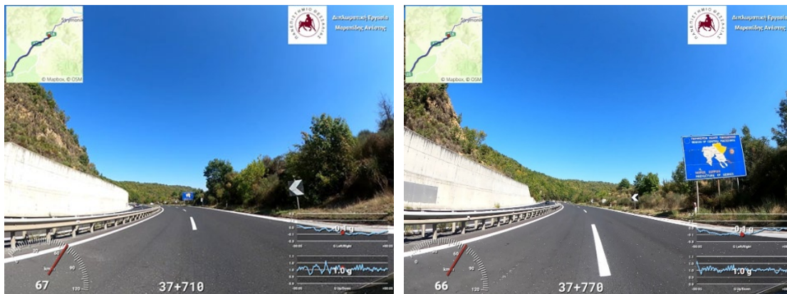
Εικόνες 5.9.4.1 και 5.9.4.2 Ενδεικτική θέση πινακίδων που βρίσκονται σε επικίνδυνη θέση, ανασφάλιστες, Χ.Θ. 37+710 και Χ.Θ. 37+770 (Δεξιός κλάδος) (Πηγή : Προσωπικό Αρχείο)
