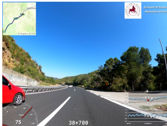
Εικόνα 5.9.2.7 Έξοδος διαμορφωμένου χώρου στάθμευσης αυτοκινήτων (Parking) πάνω σε οριζοντιογραφική καμπύλη, Χ.Θ. 38+700 (Δεξιός κλάδος) (Πηγή: Προσωπικό Αρχείο)
