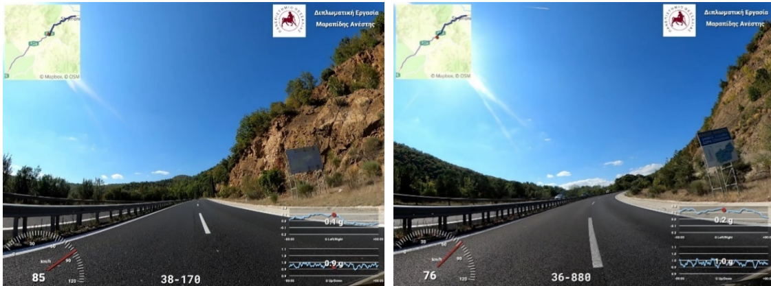
Εικόνες 5.9.4.3 και 5.9.3.4 Ενδεικτική θέση πινακίδων που βρίσκονται σε επικίνδυνη θέση, ανασφάλιστες, Χ.Θ. 38+170 και Χ.Θ. 36+880 (Αριστερός κλάδος) (Πηγή : Προσωπικό Αρχείο)
