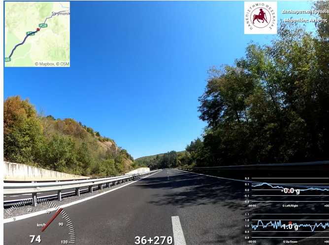
Εικόνα 5.9.1.1 Μηδενικός οδοφωτισμός στο οδικό στο υποτίμημα Β με τις διαδοχικές μικρής ακτίνας καμπύλες, Χ.Θ. 36+270 (Δεξιός κλάδος) (Πηγή: Προσωπικό Αρχείο)
