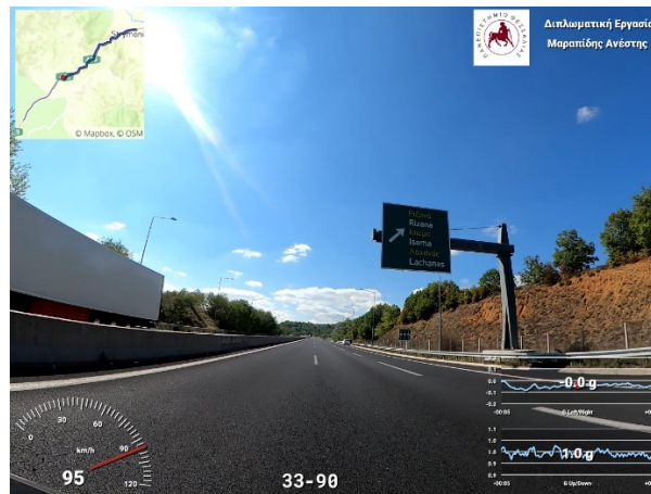
Εικόνα 5.7.2.2 Ενδεικτική εικόνα διατήρησης του πλάτους της ΛΕΑ - ερείσματος στον Α/Κ Λαχανά Χ.Θ. 33+090 (Αριστερός κλάδος) (Πηγή : Προσωπικό Αρχείο)
