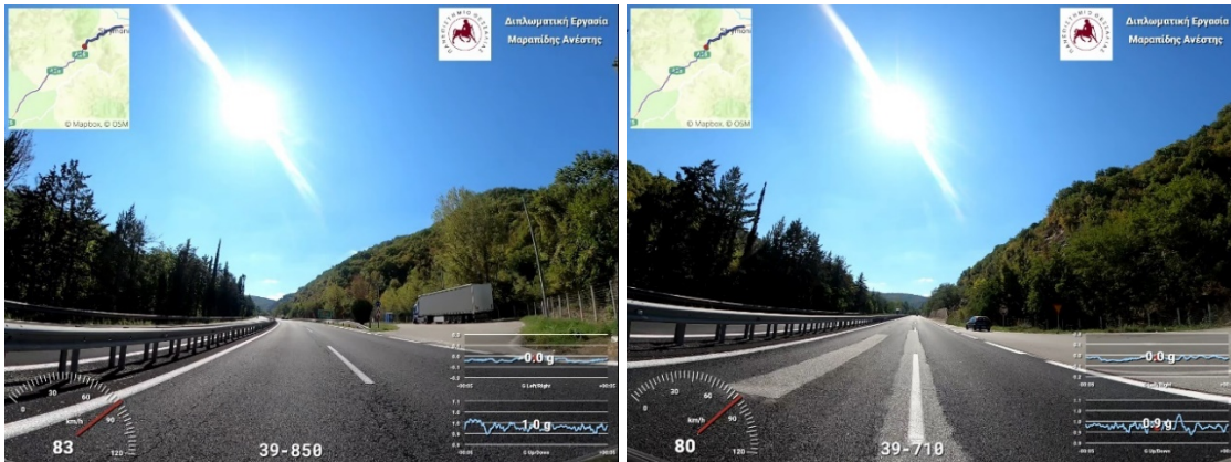
Εικόνες 5.9.2.21 και 5.9.2.22 Είσοδος και έξοδος χώρου στάθμευσης αυτοκινήτων (Αριστερός κλάδος) (Πηγή : Προσωπικό Αρχείο)
