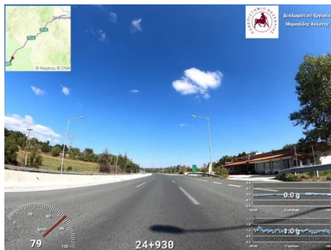
Εικόνα 5.7.1.1 Θέση εισόδου παράπλευρης ιδιοκτησία Καφέ – Εστιατορίου στη Χ.Θ. 24+930, εντός της λωρίδας επιτάχυνσης του κλάδου εισόδου του Α/Κ Ευλούπολης - (Δεξιός κλάδος) (Πηγή : Προσωπικό Αρχείο)
