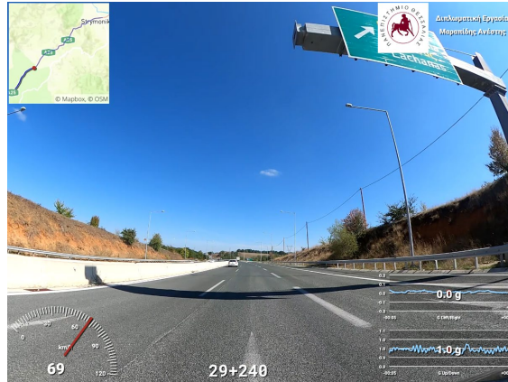
Εικόνα 5.7.2.1 Ενδεικτική εικόνα διατήρησης του πλάτους της ΛΕΑ - ερείσματος στον Α/Κ Λαχανά Χ.Θ. 29+240 (Δεξιός κλάδος) (Πηγή : Προσωπικό Αρχείο)
