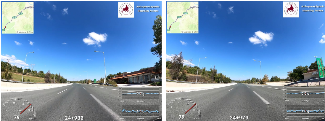
Εικόνες 5.9.2.4 και 5.9.2.5 Είσοδος και έξοδος παρακείμενης ιδιοκτησίας Καφέ – Εστιατορίου, Χ.Θ. 24+930 και Χ.Θ. 24+970 (Δεξιός κλάδος) (Πηγή : Προσωπικό Αρχείο)
