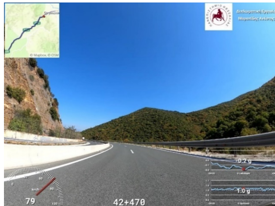
Εικόνα 5.10.4.1 Ενδεικτική θέση όπου δεν υπάρχει σήμανση Κ1α και Π-75 αν και αποτελεί την μικρότερη καμπύλη του εξεταζόμενου οδικού τμήματος ( R=200\text{ m} ), Χ.Θ. 42+470 (Δεξιός κλάδος) (Πηγή : Προσωπικό Αρχείο)
