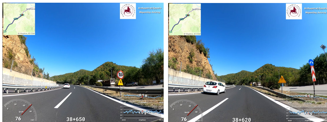
Εικόνες 5.9.3.1 και 5.9.3.2 Βανδαλισμένες και φθαρμένες με μειωμένη αντανακλαστικότητα Χ.Θ. 38+650 και Χ.Θ. 38+620 (Δεξιός κλάδος) (Πηγή : Προσωπικό αρχείο)
