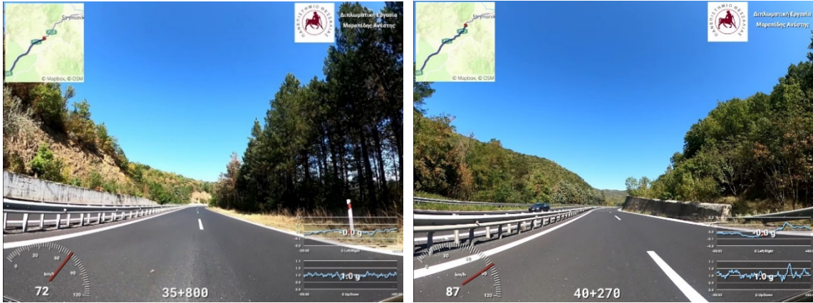
Εικόνες 5.11.2.10 και 5.11.2.11 Ενδεικτικές θέσεις που απαιτείται τοποθέτηση στηθαίων ή επέκταση ορθή συναρμογή με τείχος αναχαίτησης, Χ.Θ. 35+800 και Χ.Θ. 40+270 (Δεξιός κλάδος) (Πηγή : Προσωπικό Αρχείο)
