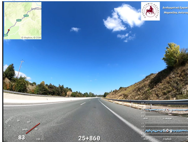
Εικόνα 5.4.1.1 Ενδεικτική φωτογραφία διατομής του δεξιού κλάδου Χ.Θ. 25+860, του οδικού τμήματος (Δεξιός κλάδος) (Πηγή : Προσωπικό Αρχείο)
