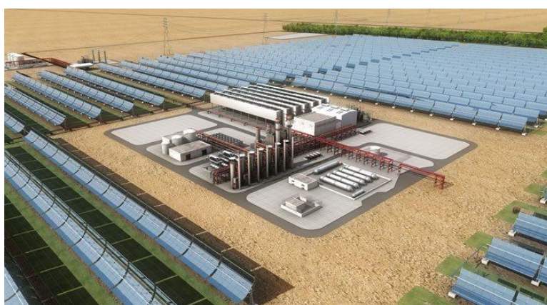
Εικόνα 43: Μονάδα αφαλάτωσης θαλασσινού νερού στη Νότια Αφρική, η οποία λειτουργεί με ηλεκτρική ενέργεια παραχθείσα από συστοιχίες ηλιακών φωτοβολταϊκών συλλεκτών. Πηγή: https://constructionreviewonline.com/
