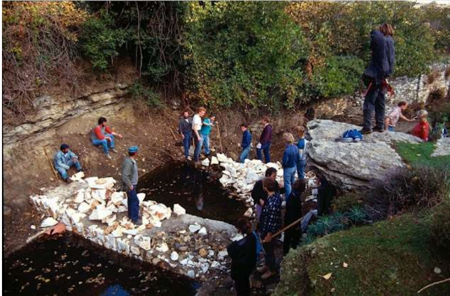
Εικόνα 2-15 Κατασκευή μικρών φραγμάτων, Απείρανθος Νάξου 1987.
