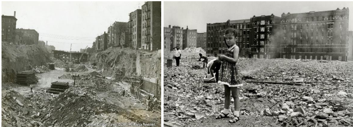
Εικόνα 3.1. Φωτογραφίες από τις εργασίες κατασκευής του αυτοκινητοδρόμου Cross Bronx Expressway. Πηγή: Vassar College
