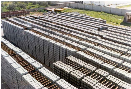
εικόνα 12: Προκατασκευή οπλισμένου σκυροδέματος
