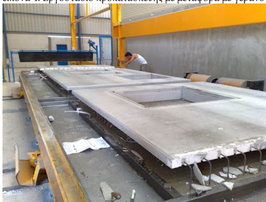
εικόνα 5: Κατασκευή σπιτιών, προκατασκευασμένα σπίτια με
