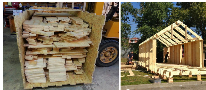
εικόνα 40: Κατασκευή του Wiki house Den Bosch
