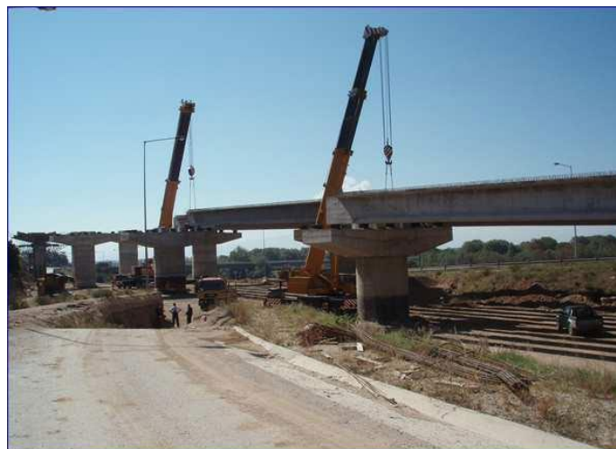
εικόνα 24: Κατασκευή γεφυρών με την μέθοδο των προκατασκευασμένων δοκών
