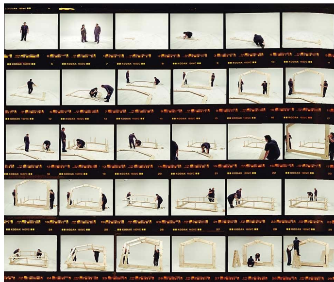
εικόνα 43: Συναρμολόγηση του Wikihouse
