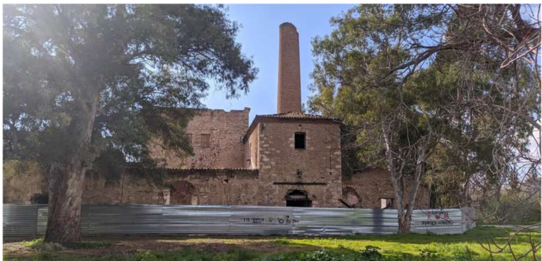
Εικόνα 25 – Τμήμα της βόρειας πτέρυγας ύστερα από την τοποθέτηση της εξωτερικής περιφράξης. Βακαλοπούλου Μ.
