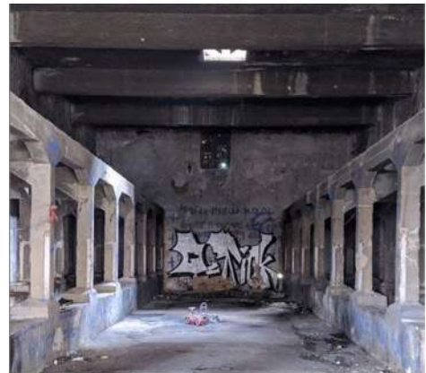
Εικόνα 24 – Βάσεις οπλισμένου σκυροδέματος για στήριξη βαρελιών. Βόρεια πτέρυγα. Βακαλοπούλου Μ.
