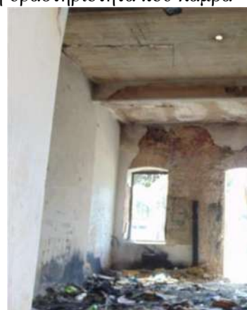
Εικόνα 12 – Εσωτερική άποψη του εργοστασίου. Αστέρι, Γκαραλιάκος, Λουκούζα.
