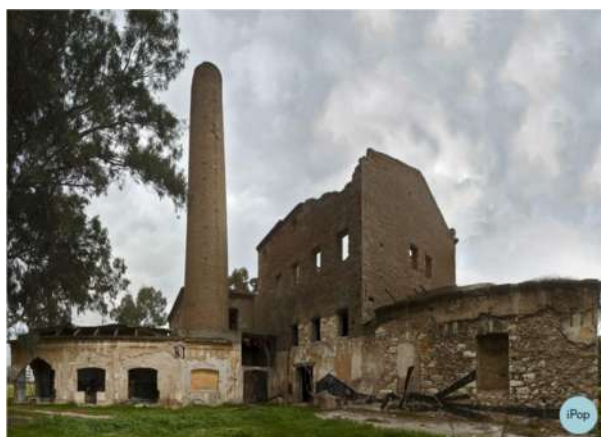
Εικόνα 18 – Η 25μέτρη καμινάδα του εργοστασίου. iPop
