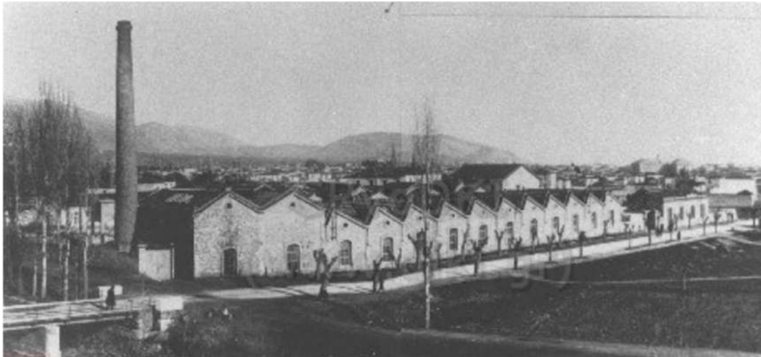
Εικόνα 11 - Το εργοστάσιο «Λεβιάθαν – Μουρτζούκου» ανήκει στον τρίτο τύπο βιομηχανικών κτηρίων με την χαρακτηριστική οδοντωτή στέγη. Αρχείο ΔΗ.Κ.Ι.
