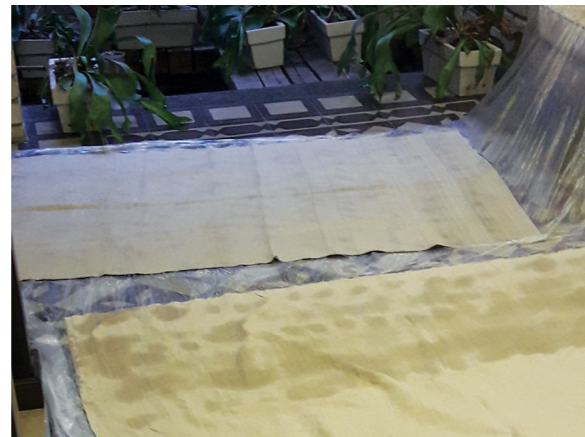
Φωτογραφία κατά την επεξεργασία αδιαβροχοποίησης.
