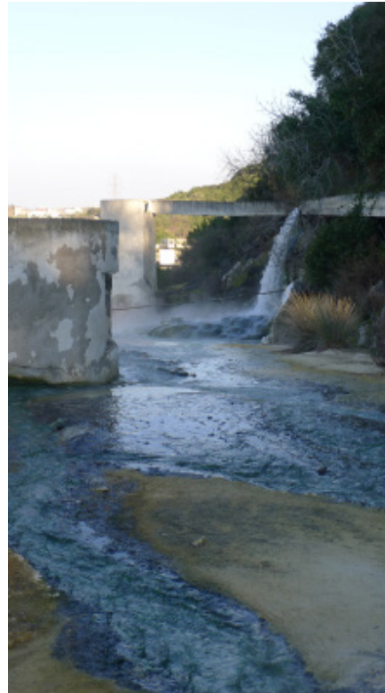
Η πορεία του ιαματικού νερού καθώς περνάει πίσω από το κτήριο του υδροθεραπευτήριου. Στα δεξιά διακρίνεται ο τεχνητός καταρράκτης.
