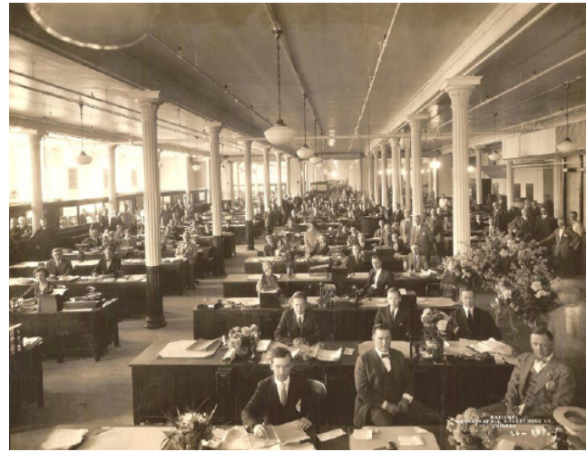
1. Γραφείο ανοιχτής διάταξης με ορθοκανονική διάταξη υποστηλωμάτων
