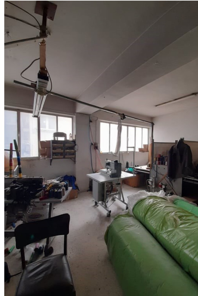
23,24. Εσωτερικό βιοτεχνικού κτιρίου στην οδό Κωστή Παλαμά 14
