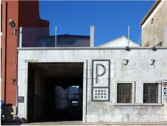
Εικόνα 55 Είσοδος του συγκροτήματος Phosphoreira πηγή: https://www.orientre.pt/vizinhos/vizinhar-dick-bachu-da-phosphoreira/
