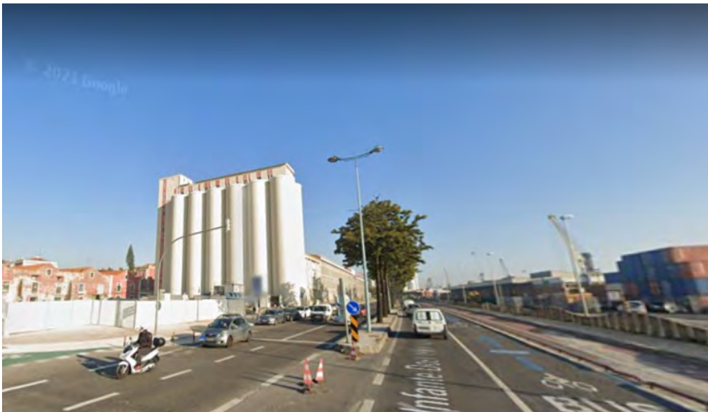
Εικόνα 26. Η λεωφόρος Infante dom Henrique στο ύψος του Beato, αριστερά το εργοστάσιο και σιλό μιας βιομηχανίας τροφίμων, δεξιά τα κοντέινερς της λιμενικής ζώνης. Πηγή: Google street view
