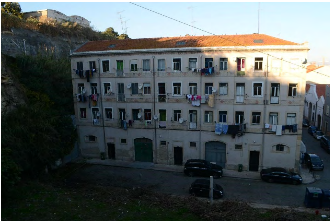
Εικόνα 45. Η πολυκατοικία στη συμβολή των οδών José Domingos Barreiros και Capitão Leitão στη „σκιά του λόφου”. Πηγή: προσωπικό αρχείο
