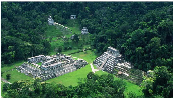
Εικόνα 5: Αεροφωτογραφία τμήματος της αρχαίας πόλης Παλένκε, Μεξικό.
