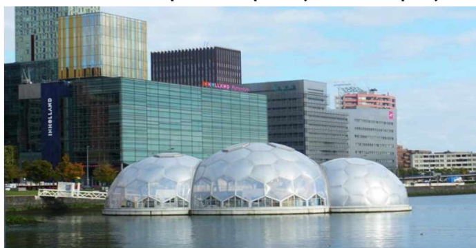
Εικόνα 54: Πλωτή κατασκευή στο λιμάνι του Ρότερνταμ
