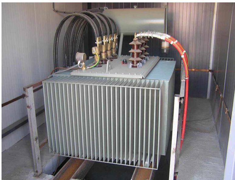
Εικόνα 2: Μετασχηματιστής ισχύος του Υ/Σ.
