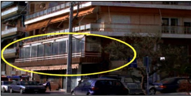
Εικόνα 1: Παράνομη ανέγερση κατασκευής σε μπαλκόνι (Πηγή: Σαμαράς, 2008)
