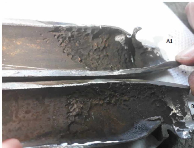
Σχήμα 4.3: Εσωτερική επιφάνεια των τμημάτων A1 και B1 στα σημεία εκδήλωσης της διάβρωσης
