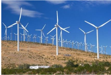
Εικόνα 5: Τριπτέρυγη πολύστροφη ΑΟΑ [8]
