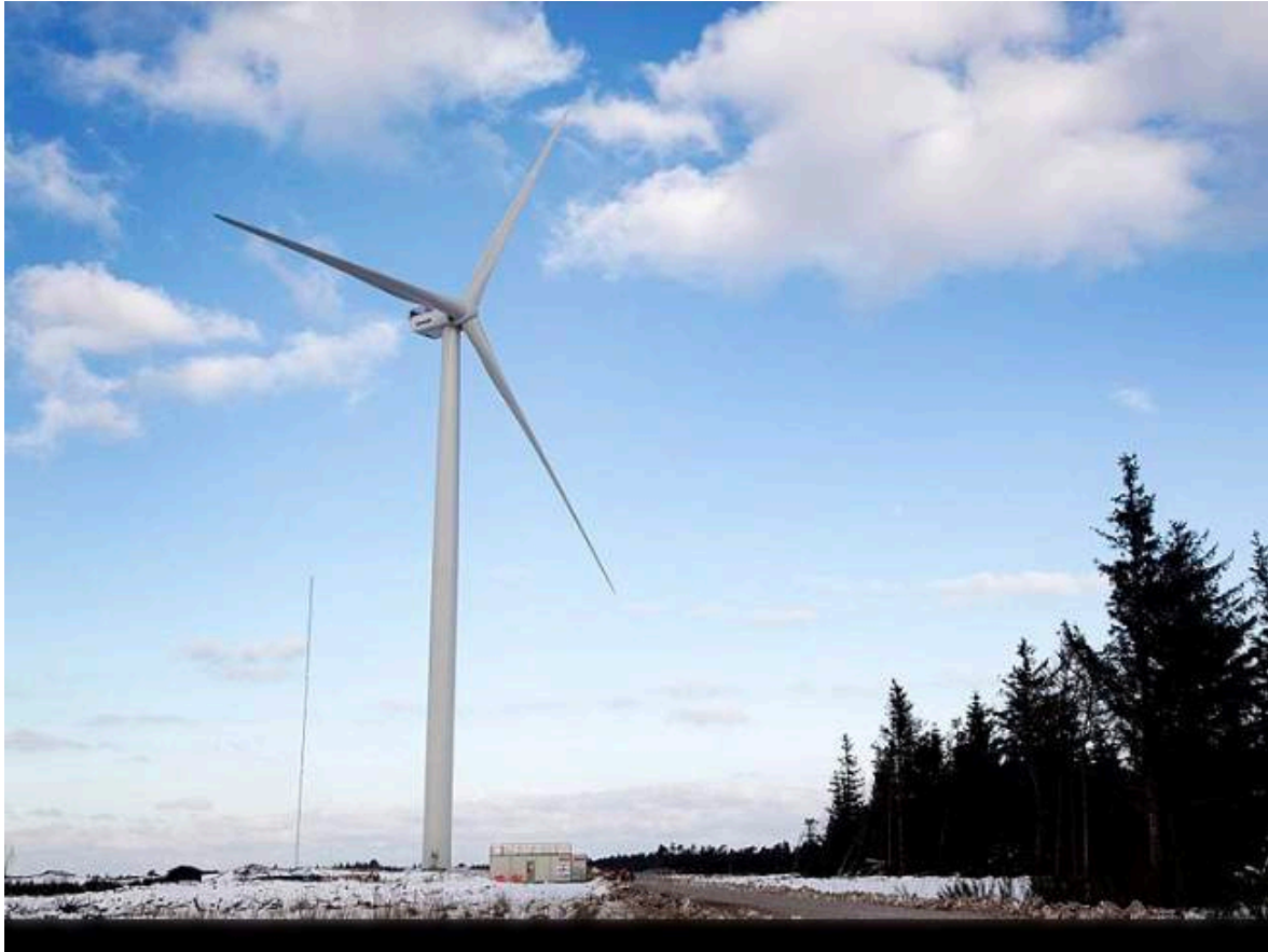
Εικόνα 6.9 : Πρωτότυπη Vestas V164 τοποθετημένη στη ξηρά.
