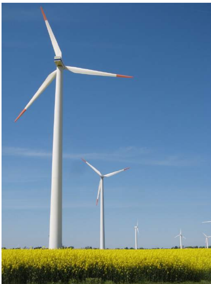
Εικόνα 6.1 Συνηθέστερη μορφή ανεμογεννήτριας ,ρότορας τριών πτερυγίων (πηγή : https://el.wikipedia.org/wiki/Ανεμογεννήτρια#/media/Αρχείο:Schuelp_bilderbuchwindraeder.JPG ).
