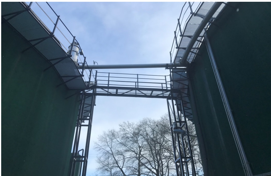
Εικόνα 33: Σωληνώσεις επικοινωνίας αντιδραστήρων
