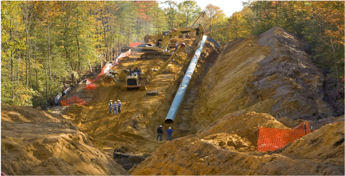
Σχήμα 2-2. Τοποθέτηση αγωγού φυσικού αερίου σε πρανές (William Taufic / Getty Images)
