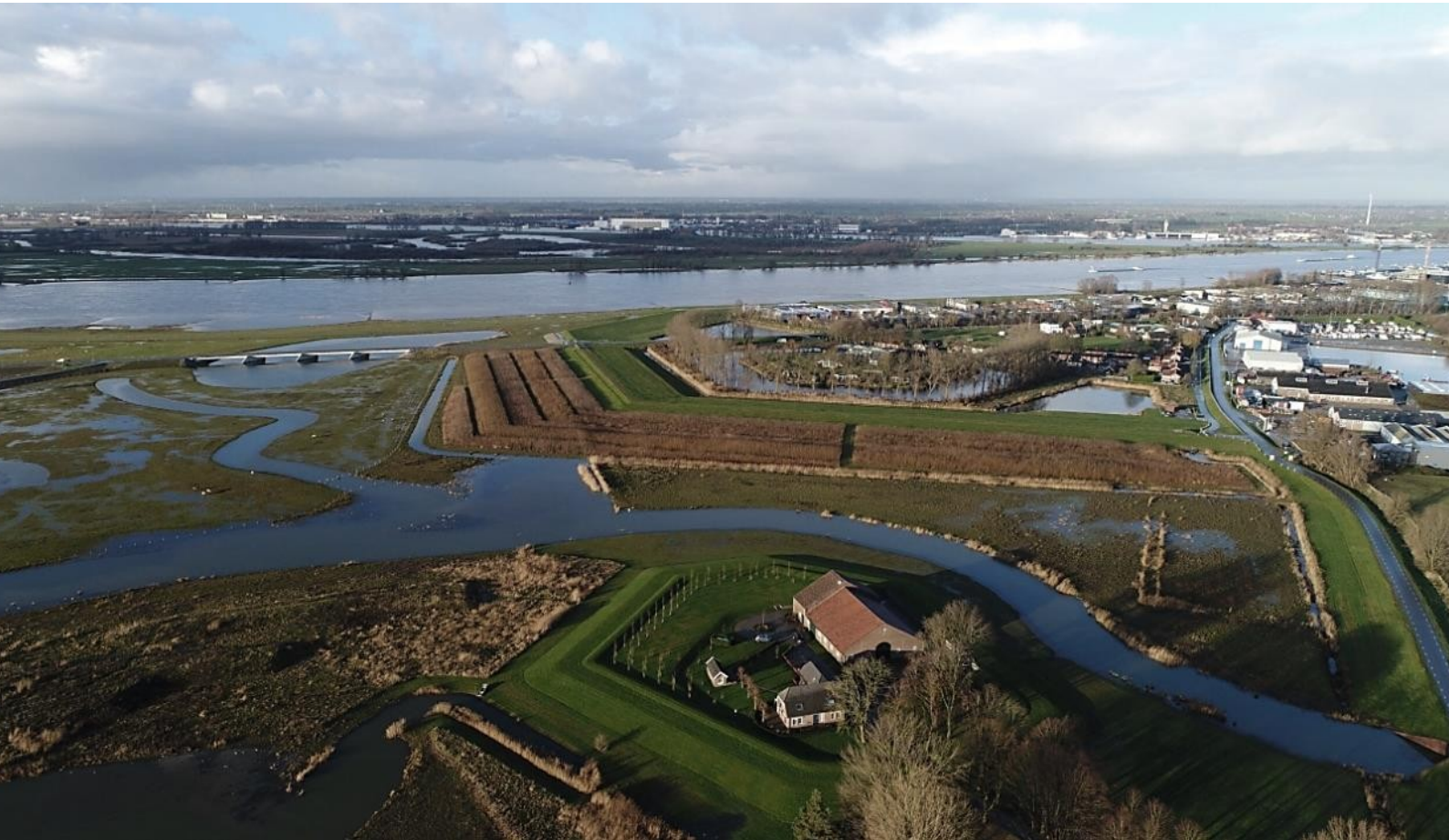
Εικόνα 14: Προστασία από τις πλημμύρες με βάση τη φύση στο Noordwaard, νοτιοδυτική Ολλανδία. Ένα διαφορετικό και υβριδικό ανάχωμα προστασίας από πλημμύρες, όπου συνδυάζει φυτεύσεις 60 με 80 μέτρων ιτιάς με πιο χαμηλά αναχώματα. Η συγκεκριμένη τεχνική συμβάλει αποτελεσματικά στην μείωση κινδύνων πλημμύρας, ενώ ταυτόχρονα προστατεύει το τοπίο της περιοχής. ( https://www.ecoshape.org/en/cases/wave-attenuating-willow-forest-noordwaard-nl/ )
