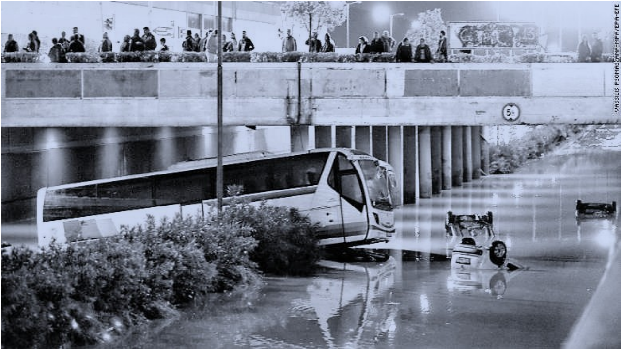
Εικόνα 16: Επιπτώσεις της πλημμύρας στο βασικό οδικό δίκτυο της περιοχής. (Διαδίκτυο)
