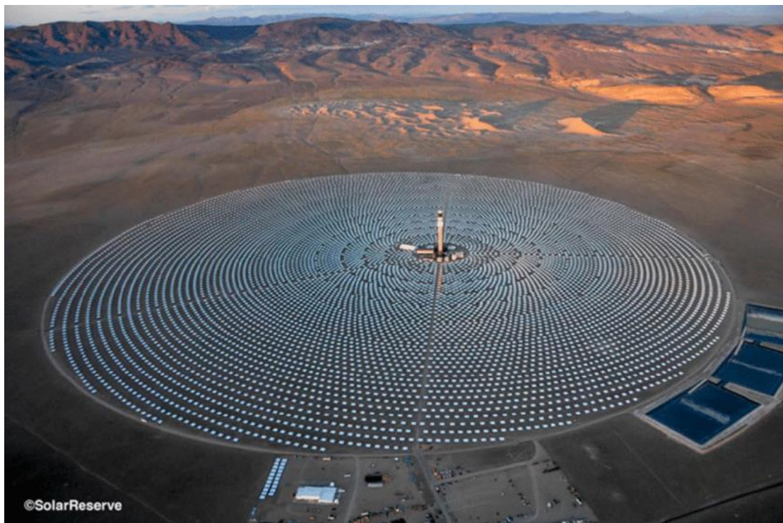
Σχήμα 3- 11. Η ηλιοθερμική εγκατάσταση CRESCENT DUNES [30].
