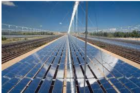
Σχήμα 1- 7. Συστήματα συλλεκτών γραμμικών ανακλαστήρων Fresnel [17].
