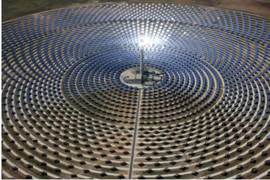
Σχήμα 1- 10. Συστήματα κεντρικού δέκτη [20].
