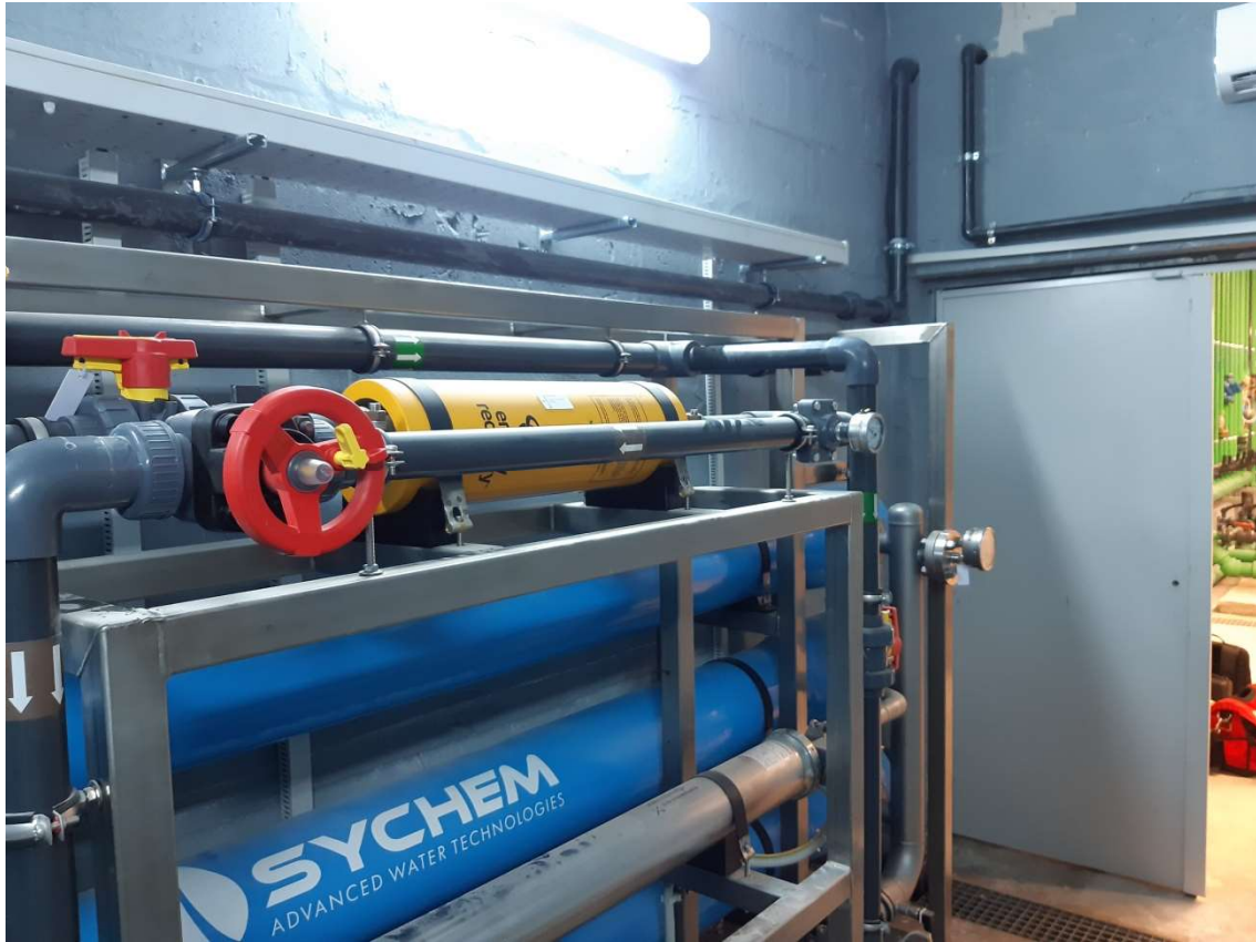
Εικόνα 5-11 Φωτογραφική απεικόνιση εναλλάκτη πίεσης
