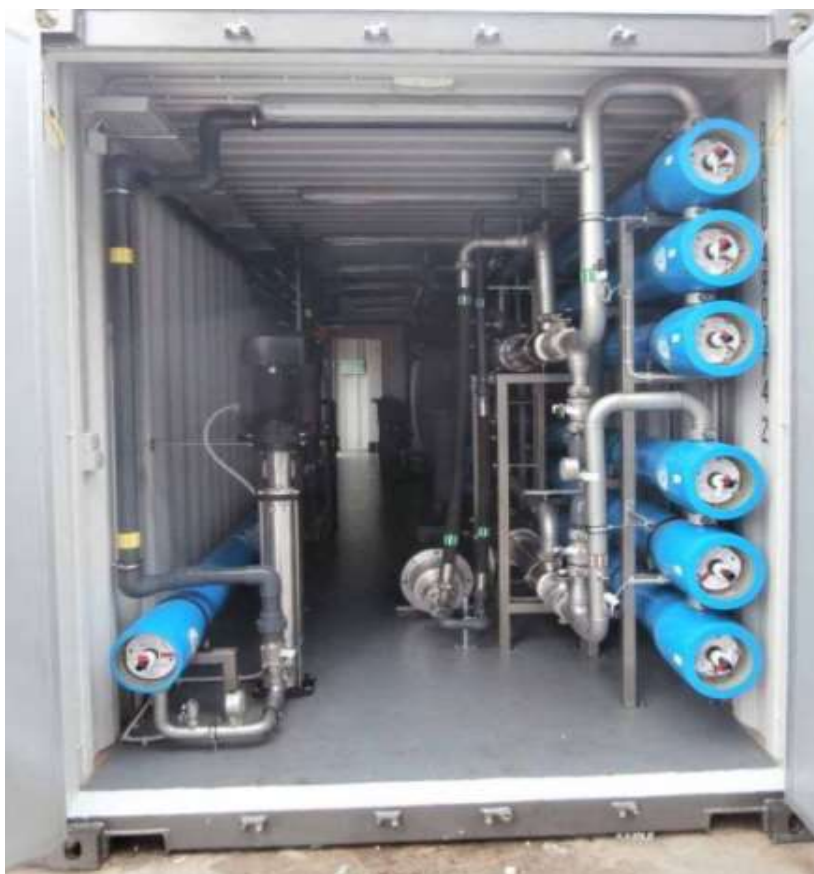
Εικόνα 1-8 Εγκατάσταση μονάδας RO σε container στα χυτά Τρικάλων
