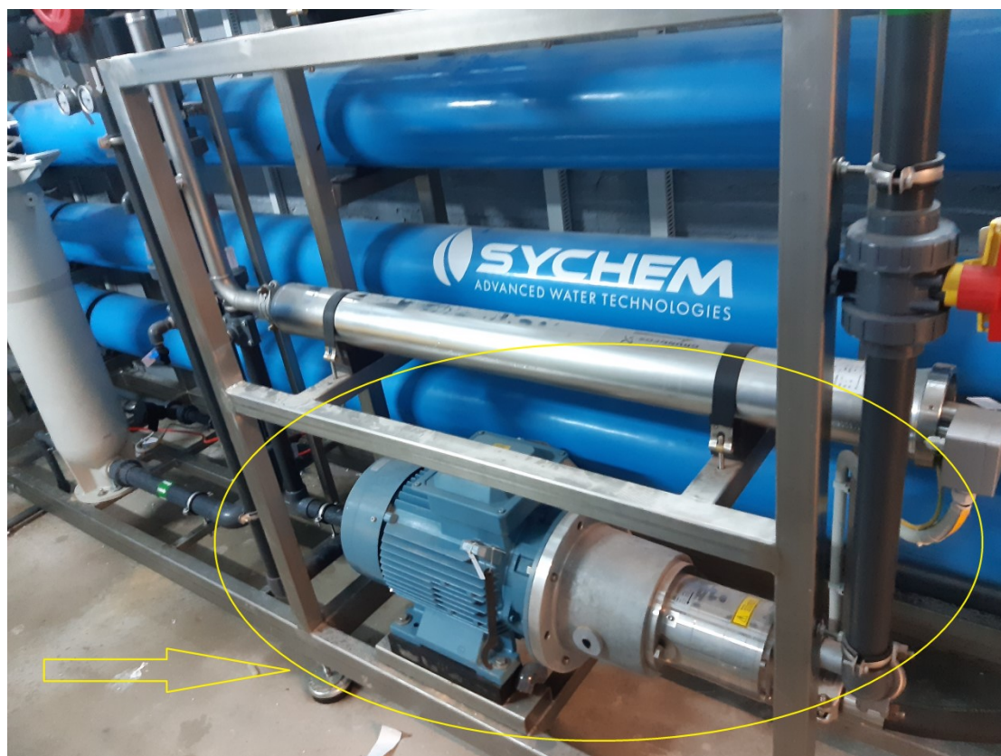
Εικόνα 5-9 Αντλία υψηλής πίεσης Danfoss APP 8.2
