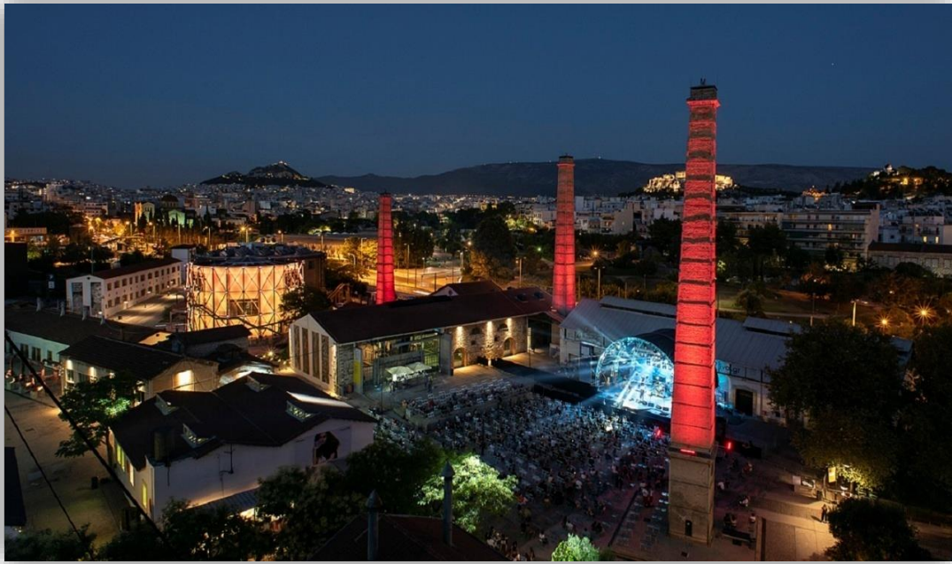
Εικόνα 37 : Τεχνόπολη στο Γκάζι Πηγή: https://athens-technopolis.gr/index.php/el/
