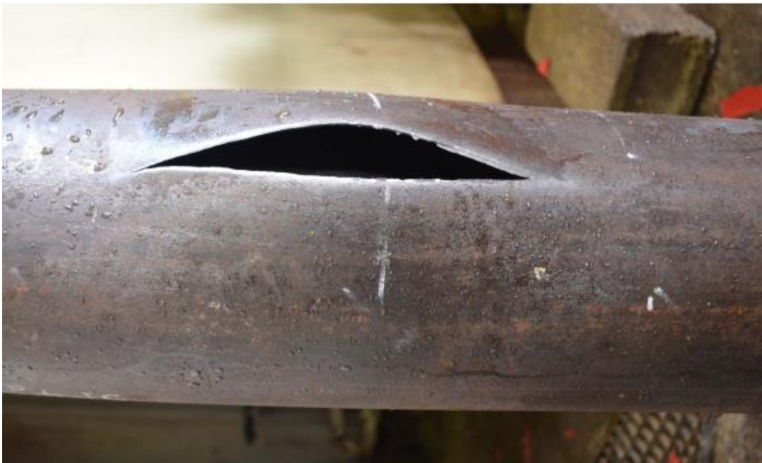
Εικόνα 1.16 Διάρρηξη αγωγού λόγω εσωτερικής πίεσης, [2].
