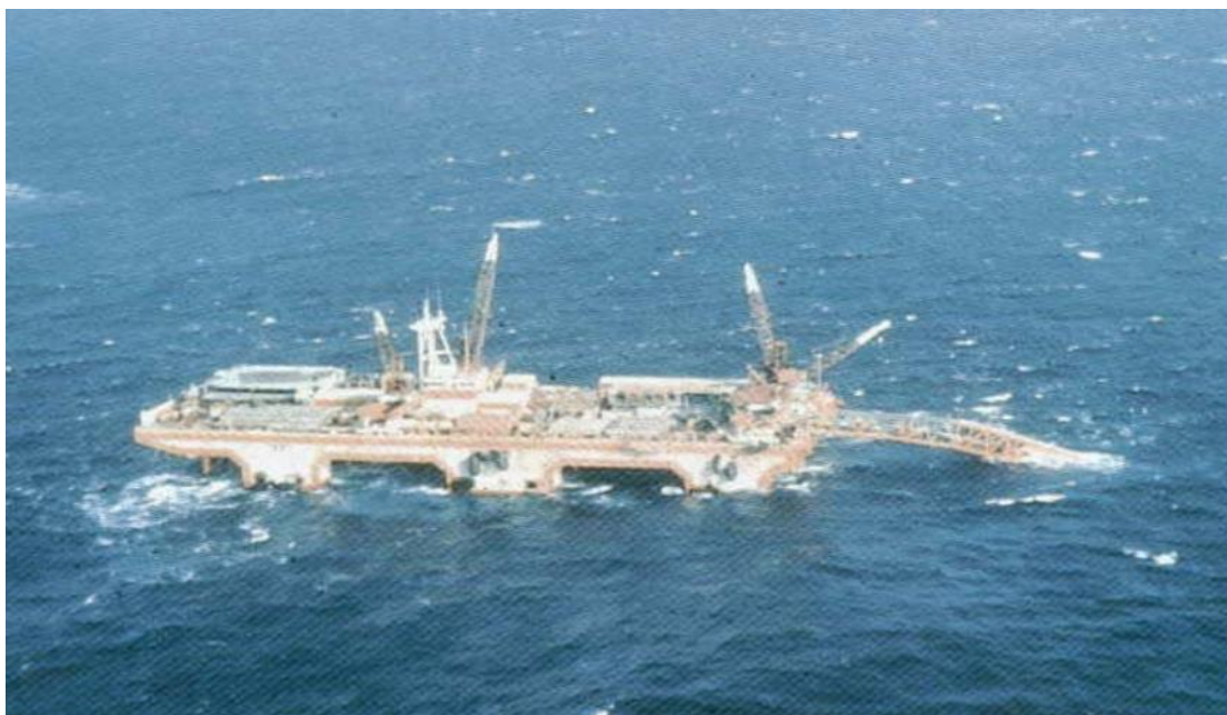
Εικόνα 1.24 Σκάφος κατασκευής υπεράκτιου αγωγού με μέθοδο S-Lay, [3].
