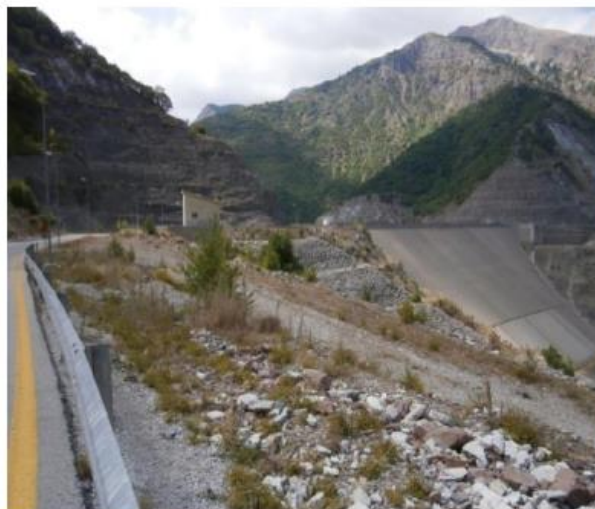
Εικόνα 14: Φράγμα Μεσοχώρας, 2015 (ανατολική άποψη)
