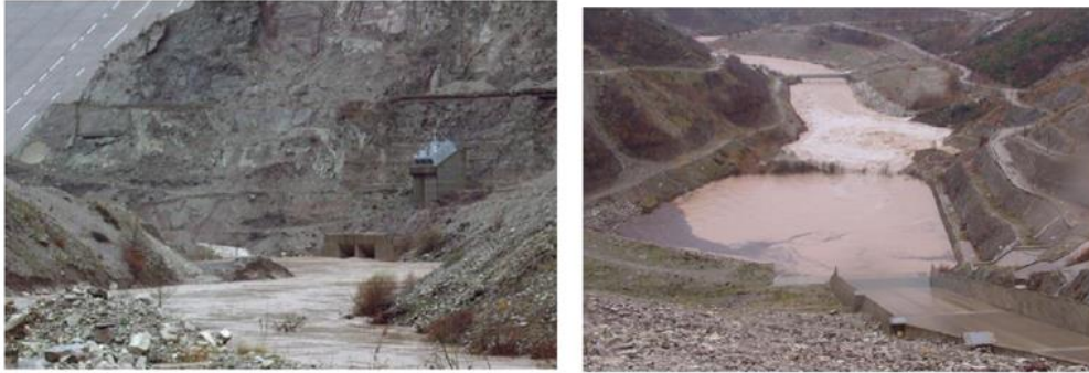
Εικόνα 13: Είσοδος σήραγγας εκτροπής-Έξοδος σήραγγας εκτροπής
