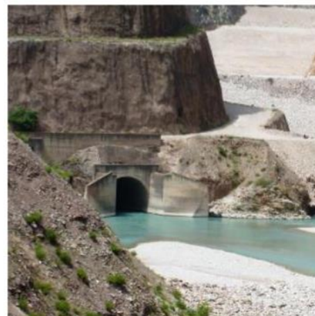
Εικόνα 6: Είσοδος και έξοδος σήραγγας εκτροπής-Φράγματος Ιλαρίωνα
