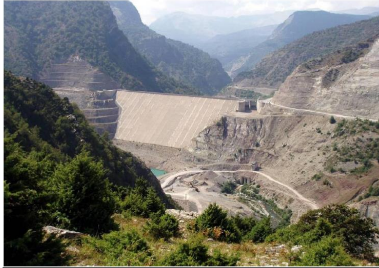
Εικόνα 12: Γενική άποψη του φράγματος της Μεσοχώρας
