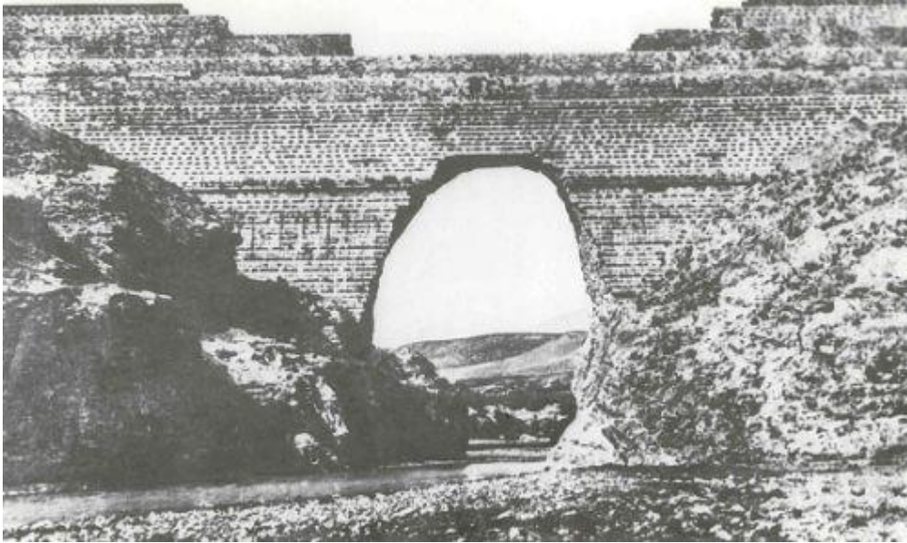
Εικόνα 4: Κατάντη Άποψη του 2ου φράγματος Puentes
