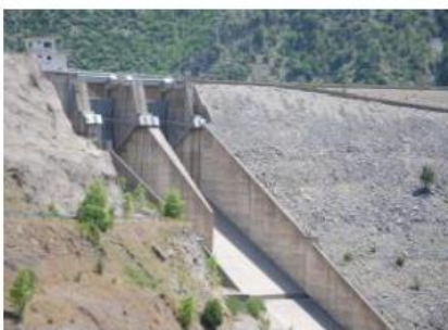
Εικόνα 17: Ο εκχειλιστής του φράγματος (1) Διώρυγα (2) Θυροφράγματα
