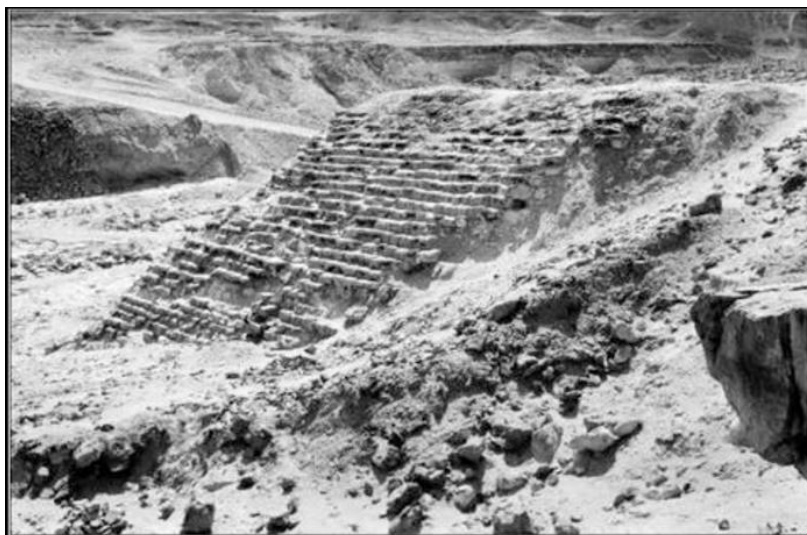
Εικόνα 2: Ανάντη των ερεψίων του φράγματος Sadd-el-Kafara
