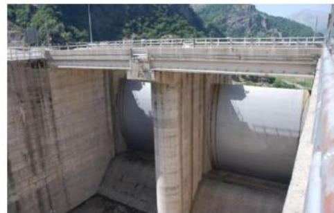
Εικόνα 17: Ο εκχειλιστής του φράγματος (1) Διώρυγα (2) Θυροφράγματα
