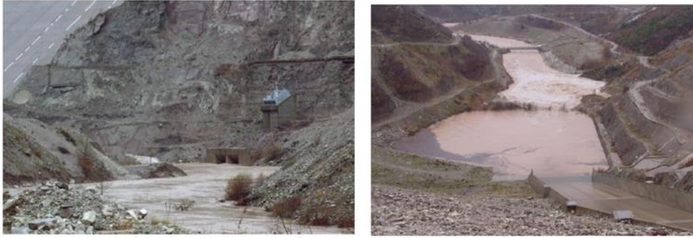
Εικόνα 13: Είσοδος σήραγγας εκτροπής-Έξοδος σήραγγας εκτροπής
