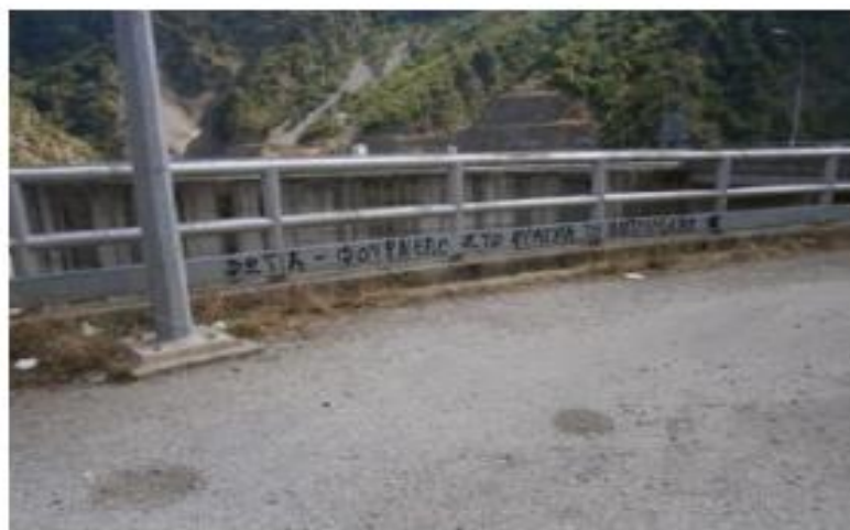
Εικόνα 15: Ανατολική είσοδος στο φράγμα (από Μεσοχώρα)
