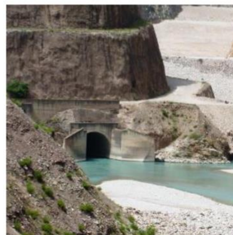
Εικόνα 6: Είσοδος και έξοδος σήραγγας εκτροπής-Φράγματος Ιλαρίωνα
