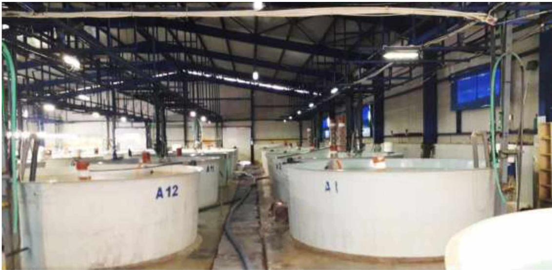
Εικόνα 13. Τμήμα αποκοπής ιχθυογεννητικού σταθμού.
