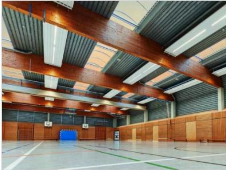
Εικόνα 3-7: Υδραυλικό πάνελ οροφής παράλληλης ροής ( https://www.zehndergroup.com/de/produkte-und-loesungen/geschaeftsfelder-und-produktlinien )
