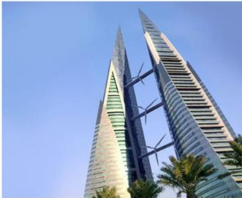
Εικόνα 1-1 Ενσωμάτωση ανεμογεννητριών στην αρχιτεκτονική κτιρίων(Γαρμπής, 2019)
