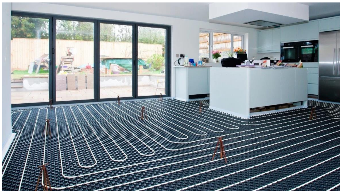
Εικόνα 0-6:Υδραυλικό σύστημα ενδοδαπέδιας θέρμανσης με διάταξη σερπαντίνας
