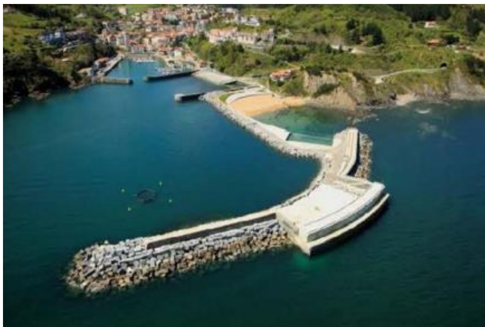
Εικόνα 4.3: Το OWC Mutriku τοποθετημένο σε κυματοθραύστη, (Perez-Collazo, 2015)
