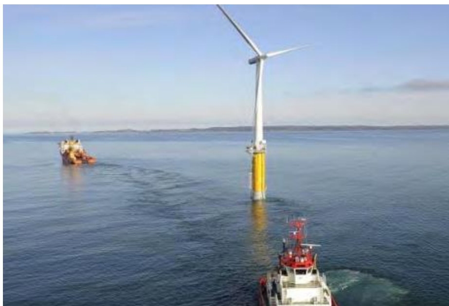
Εικόνα 3.8: Μεταβατικό κομμάτι (κίτρινο) και ανεμογεννήτρια (λευκό), (Kaiser and Snyder, 2010)
