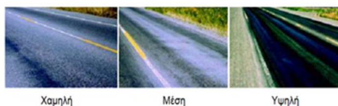
Εικόνα 2.8 «Επίπεδα σοβαρότητας του φαινομένου ανάδυσης της ασφάλτου»
