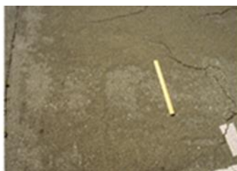
Εικόνα 2.6 «Αποκόλληση αδρανών»
