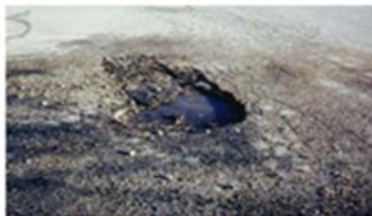
Εικόνα 2.7 «Υψηλής σοβαρότητας λακούβα»
