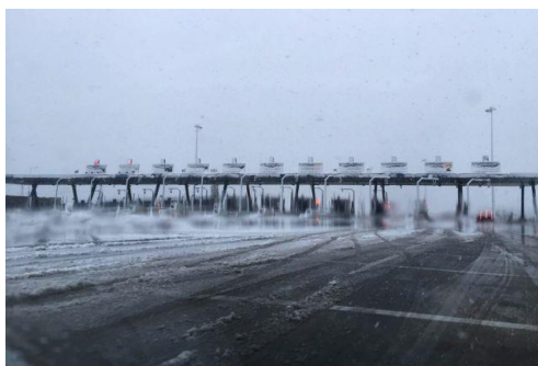
Εικόνα 4.8 «Σταθμός διοδίων στη Εθνική Οδό Αθηνών Λαμίας εν μέσω κακοκαιρίας 2019»
