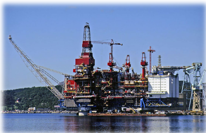
Σχήμα 3.10 - Κατασκευή πλατφόρμας εξόρυξης Gulffalks field
