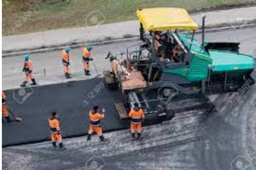
Εικόνα 3.7 Finisher Πηγή: ([6], χ.χ.)
