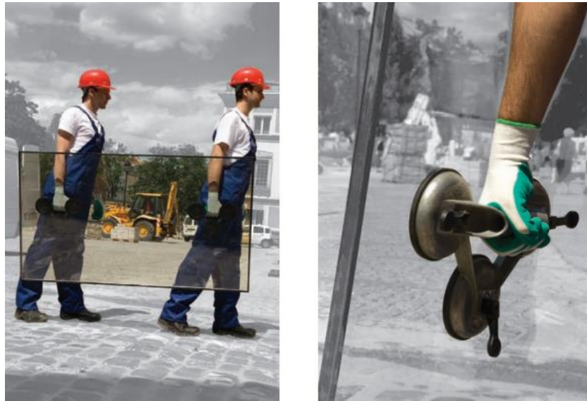
Εικόνα 3.10 Βεντούζες που χρησιμοποιούνται για τη χειρωνακτική διακίνηση υαλοπινάκων Πηγή: (tkm.tee.gr)
