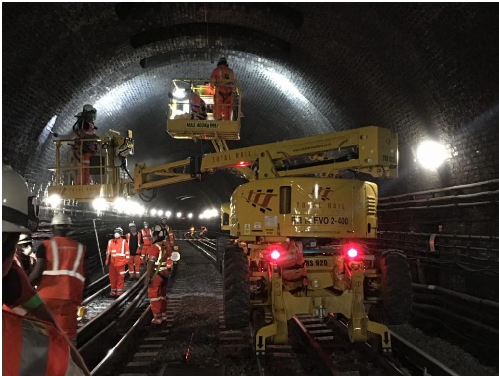
Εικόνα 3.12 Χρήση ηλεκτρονικής πλατφόρμας ανύψωσης σε εργασίες εκτελούμενες σε σήραγγα.
