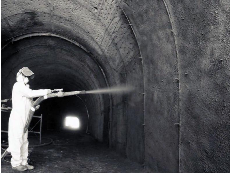
Εικόνα 3.6 Εργασίες Gunite σε σήραγγες - απαραίτητος εξοπλισμός Πηγή: ([9], χ.χ.) Ημερομηνία πρόσβασης 25/5/2021
