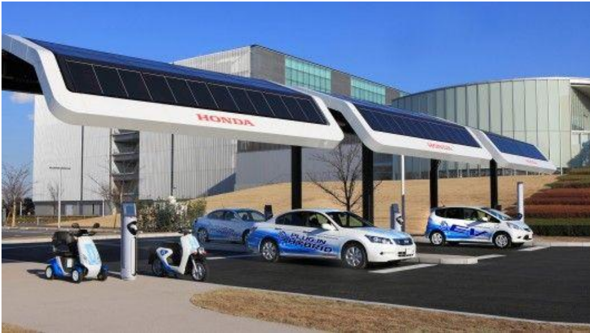
Εικόνα 4.6: Εγκατάσταση με φωτοβολταϊκά στα σημεία φόρτισης
