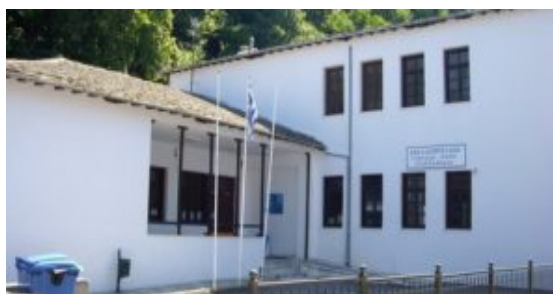
Εικόνα 13: Νέο κτίσμα όπου στεγάζονται το Γυμνάσιο και το Λύκειο της Τσαγκαράδας.
