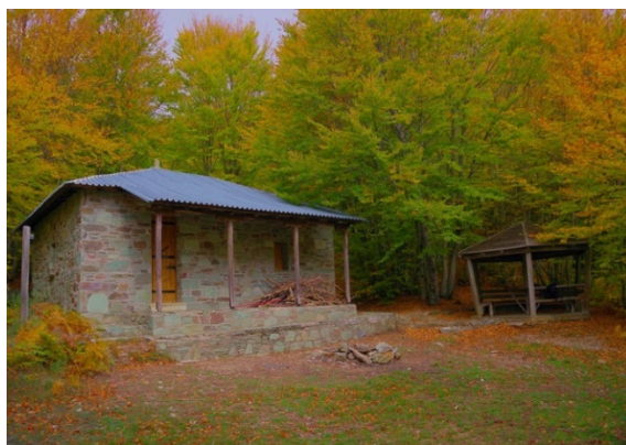
Εικόνα 63: Το καταφύγιο ανάγκης Αγίου Γεωργίου στη θέση Εξαγκαθιά.
