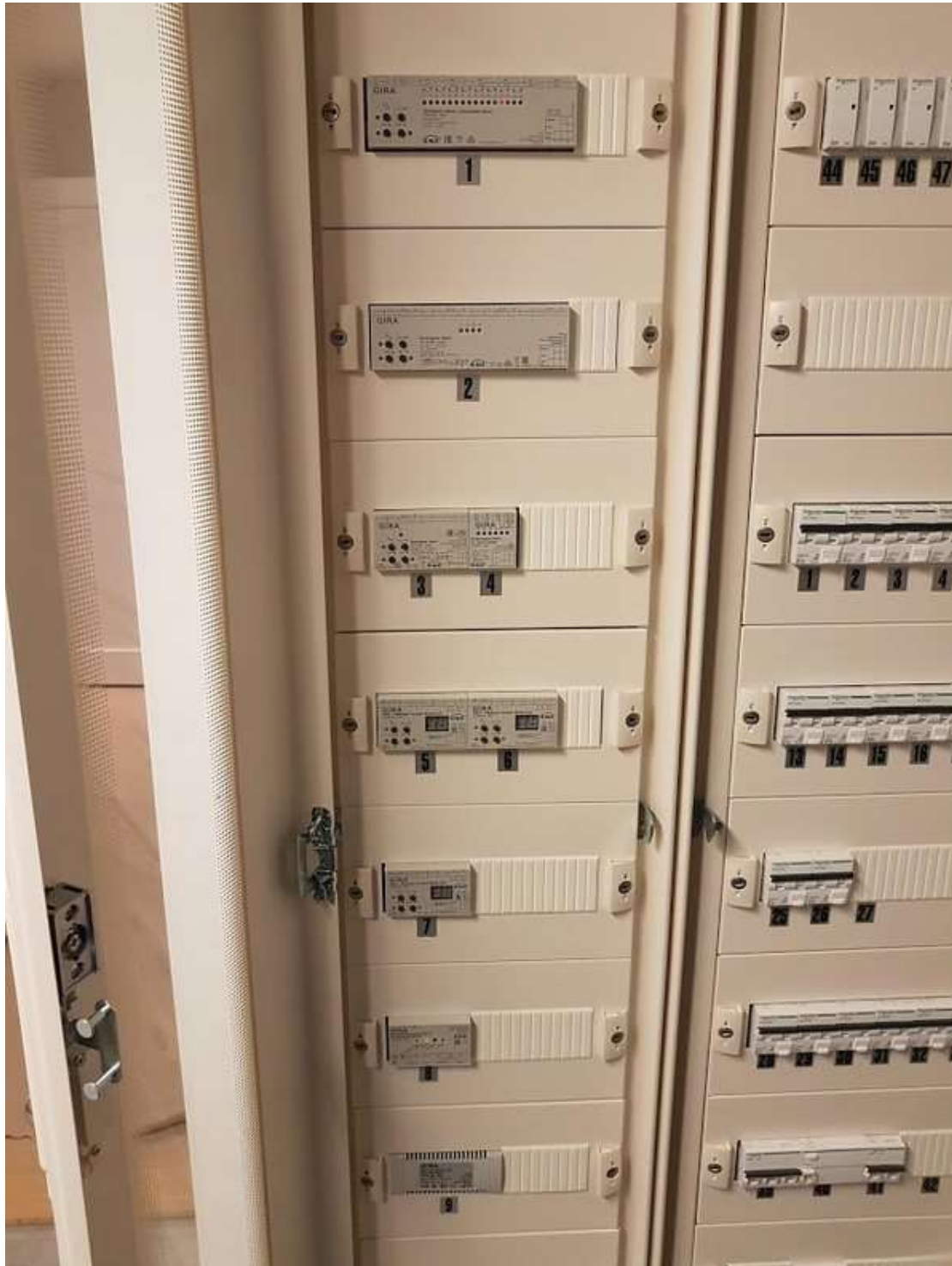
Εικόνα 21 Τα DALI σε μια εγκατάσταση
