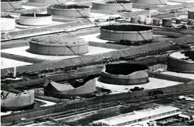
Εικόνα 22 Αστοχία δεξαμενών ανοιχτής οροφής Σάντα Κρουζ, Τυφώνας Hugo 1989
