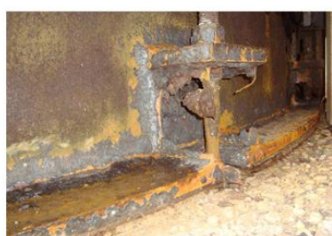
Εικόνα 32 Περιπτώσεις αστοχιών των συνδέσεων της βάσης
