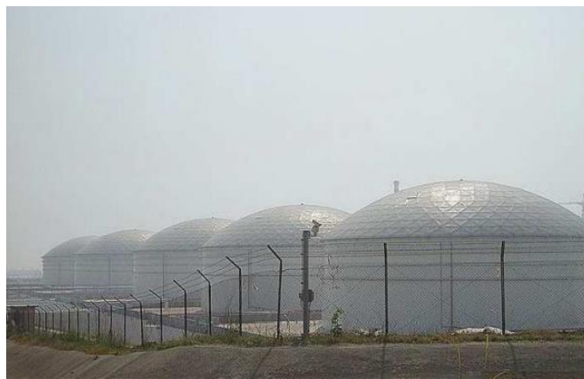
Εικόνα 16 Θολωτές οροφές αλουμινίου
