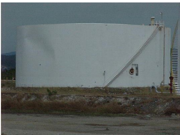
Εικόνα 20 Λυγισμός δεξαμενής -Πουέρτο Ρίκο, Τυφώνας Georges 1998
