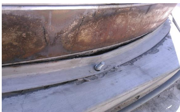
Εικόνα 33 Φαινόμενο ανόδου μπουλονιών στη βάση
