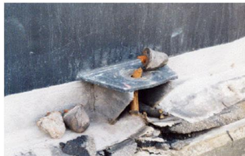
Εικόνα 31 Αστοχία θεμελίωσης
