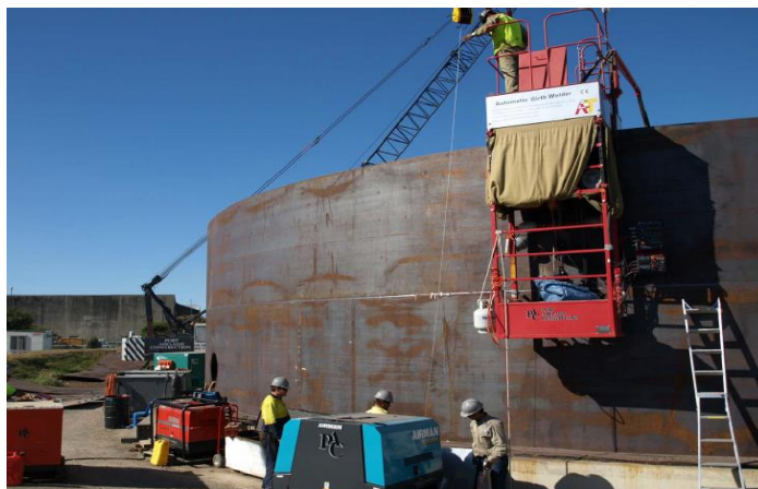
Εικόνα 10 Συγκολλήσεις των ελασμάτων δεξαμενής στο εργοτάξιο
