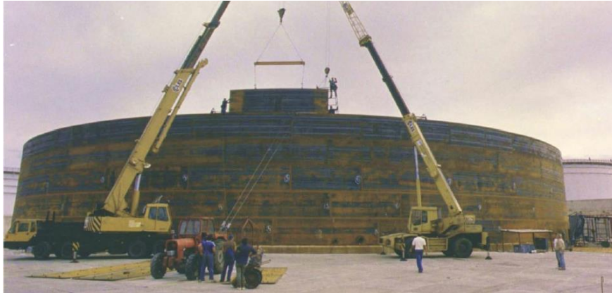
Εικόνα 14 Ανέγερση χαλύβδινης δεξαμενής
