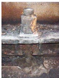
Εικόνα 32 Περιπτώσεις αστοχιών των συνδέσεων της βάσης
