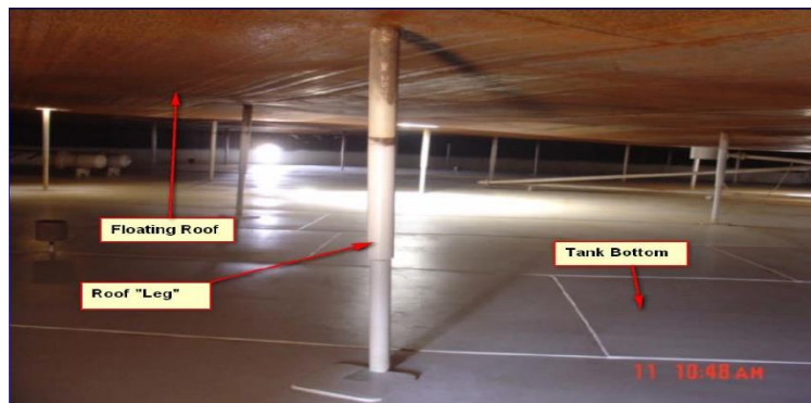
Εικόνα 6 Επιπλέουσα οροφή
