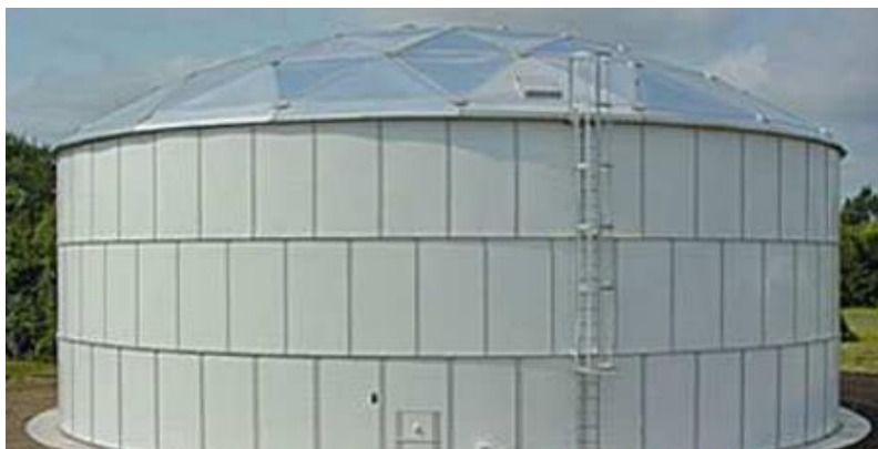
Εικόνα 8 Δεξαμενή με συγκολλητές συνδέσεις
