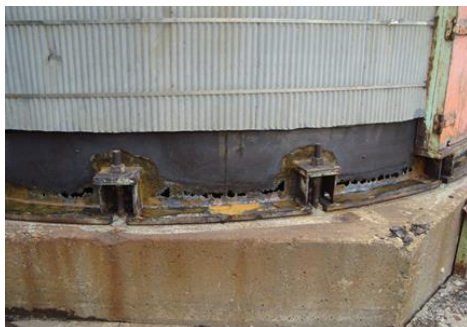
Εικόνα 31 Αστοχία θεμελίωσης
