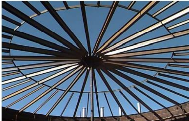
Εικόνα 15 Κεντρικά στηριζόμενη δεξαμενή
