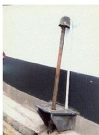
Εικόνα 32 Περιπτώσεις αστοχιών των συνδέσεων της βάσης
