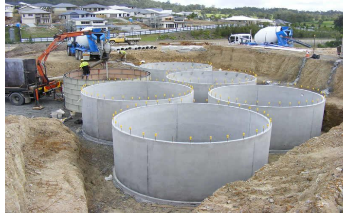
Εικόνα 2 Υπόγειες μεταλλικές δεξαμενές
