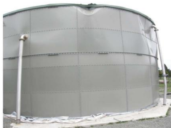
Εικόνα 31 Αστοχία θεμελίωσης
