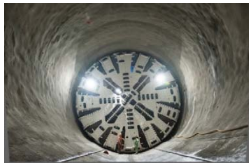
Εικόνα 3.2 - Διάνοιξη με TBM
