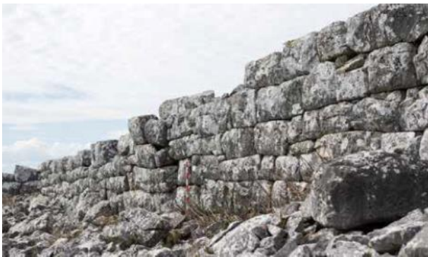
Εικόνα 1.13.7 - Βλοχός. Η εξωτερική πλευρά των τειχών της ελληνιστικής περιόδου (Vaïoroulou et al. 2020, 38, εικ. 34).
