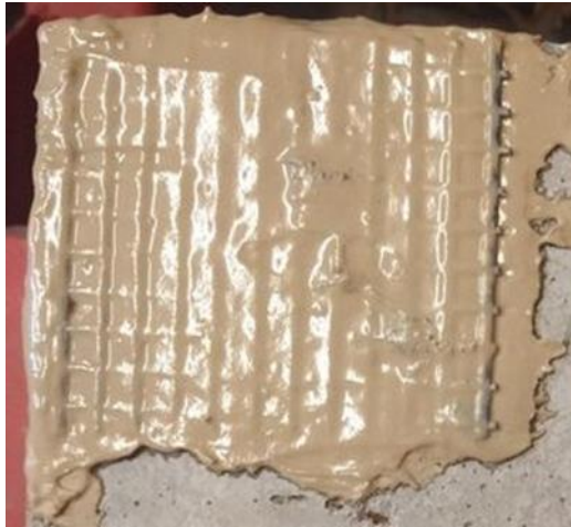
Σχήμα 3.12 Εφαρμογή κονιάματος σε επιφάνεια σκυροδέματος με ινόπλεγμα
