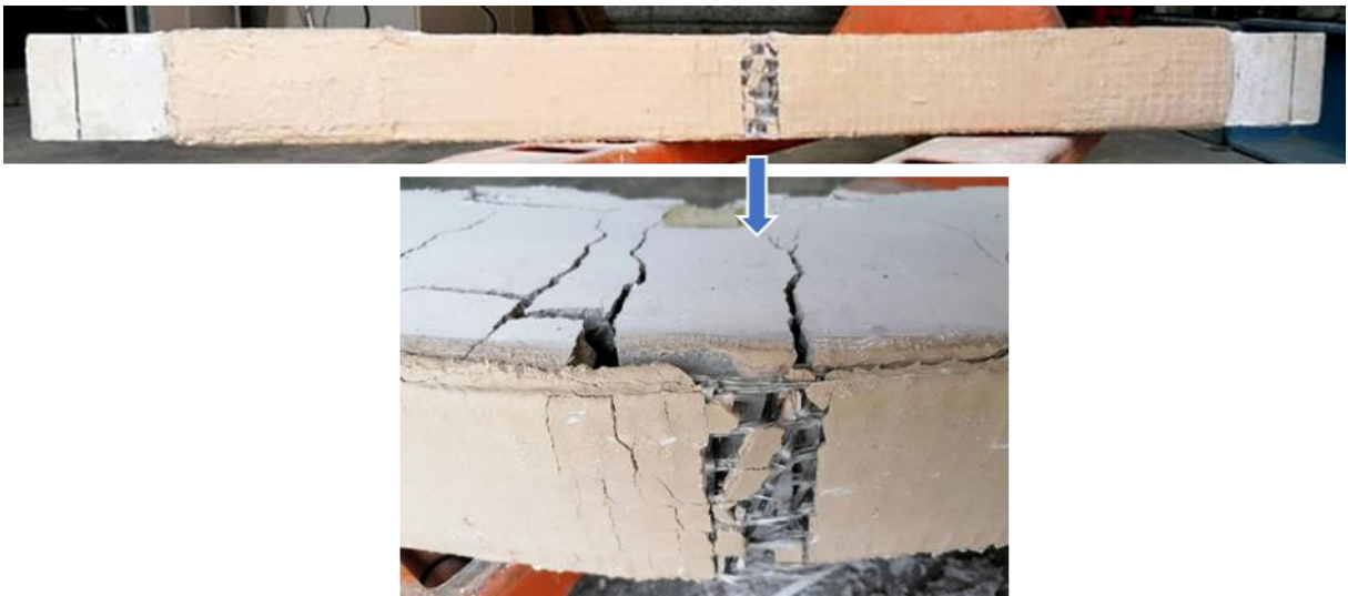
Σχήμα 4.31 (α) Όψη ενίσχυσης μετά την αστοχία, (β) κοντινή όψη ρωγμών και ινών υάλου μετά τη θραύση
