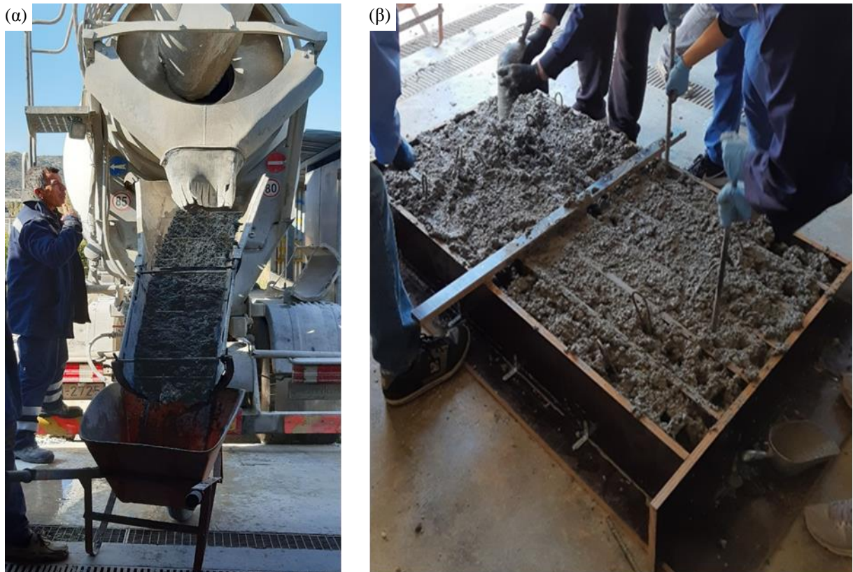
Σχήμα 3.18 (α) Έκχυση σκυροδέματος σε καρότσι (β) εκφόρτωση σκυροδέματος στα καλούπια και διάστρωση
