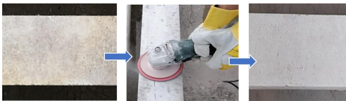
Σχήμα 3.23 Διαδικασία προετοιμασίας των επιφανειών δοκού
