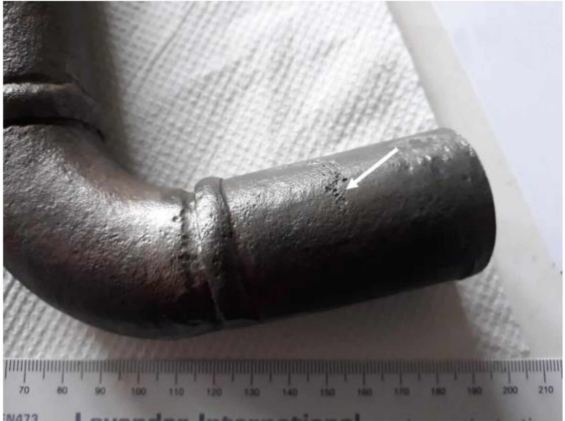
Εικόνα 33: Το βέλος υποδεικνύει σπές (pits) στην επιφάνεια του σωλήνα, κοντά στην γωνιακή σύνδεση. [23]
