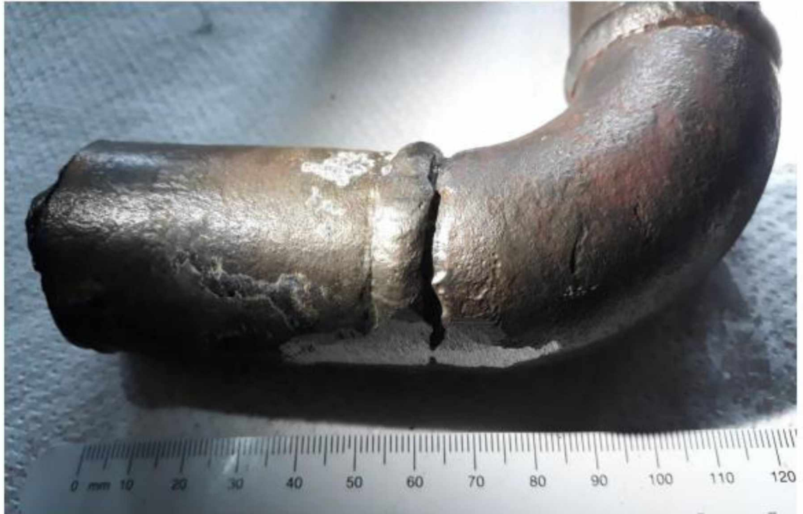
Εικόνα 32: Διάβρωση στην περιοχή των συγκολλήσεων. Τα προϊόντα διάβρωσης φαίνονται με άσπρο χρώμα. [23]
