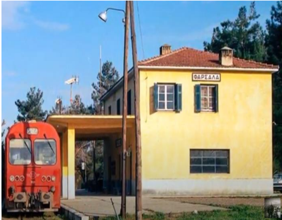
Εικόνα 13: Σιδηροδρομικός Σταθμός Φαρσάλων
