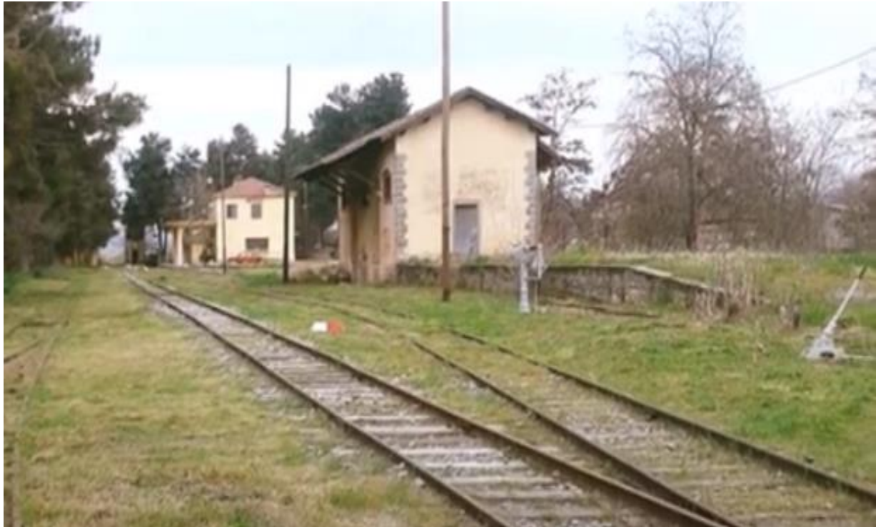
Εικόνα 16: Σιδηροδρομικός σταθμός Φαρσάλων.
