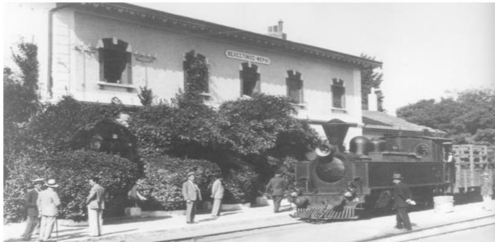
Εικόνα 11: Σιδηροδρομικός Σταθμός Βελεστίνου
